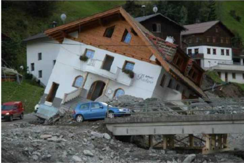
Figure (1.5) : Effet redoutable d'un affouillement [Paznauntal, Tirol, Août 05]
