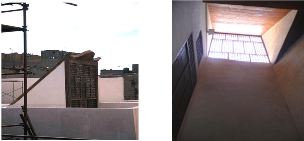
Fig.3.5. Vue extérieur et intérieur du Malqaf [El-Shorbagy, 2010].
