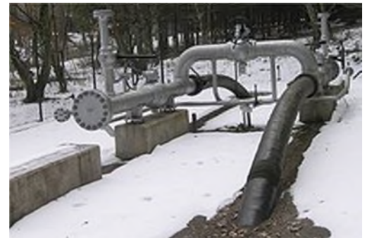
Figure 1.2 : Poste de coupure [3]
