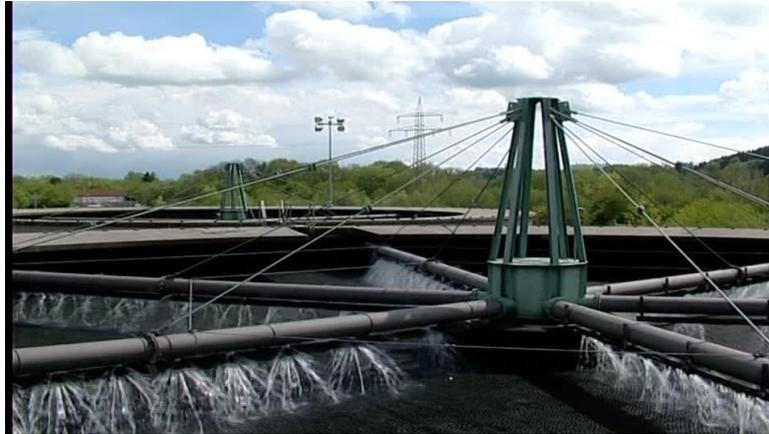
FIGURE 1.9 – Lit Bactérien-Station d'Épuration (Allemagne)
