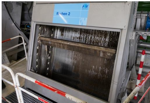
FIGURE 1.3 – Photo d'un dégrilleur [47]
