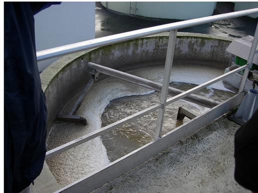
FIGURE 1.5 – Photo d'un dégraisseur [47]
