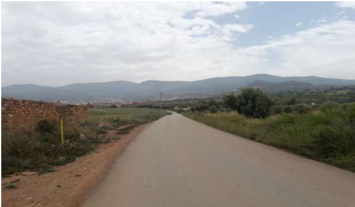
PK 1+606 de l'évitement
