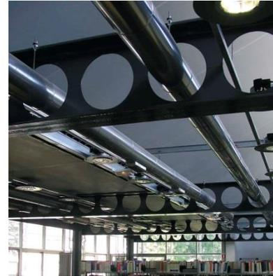
**Figure I.28 : poutre ajouré permettant le passage de canalisation suspendue et chemin de câble**
