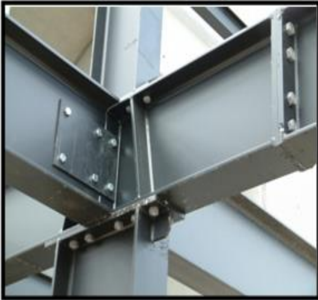
Figure I.15. Assemblage par boulonnage Source : DÉTOLLE Jacques 6
