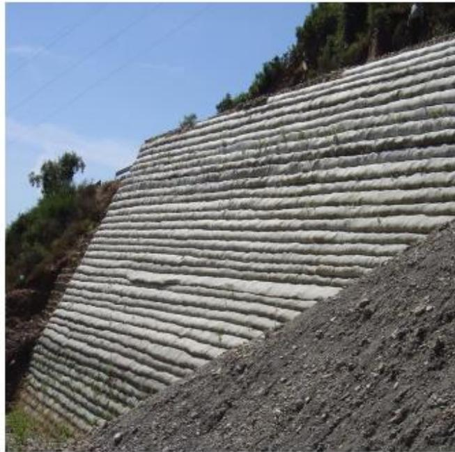
**Figure 2-18** Mur de soutènement renforcé par géotextile(TABTI, 2016)
