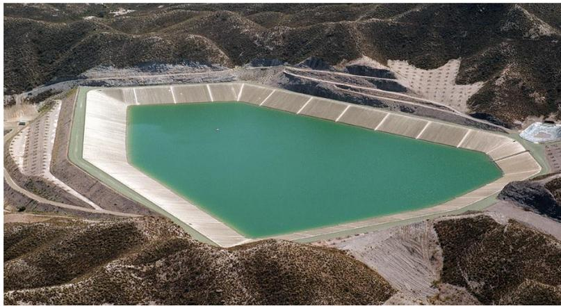
**Figure1-7** Les géomembranes (sealeco.com, s.d.)
