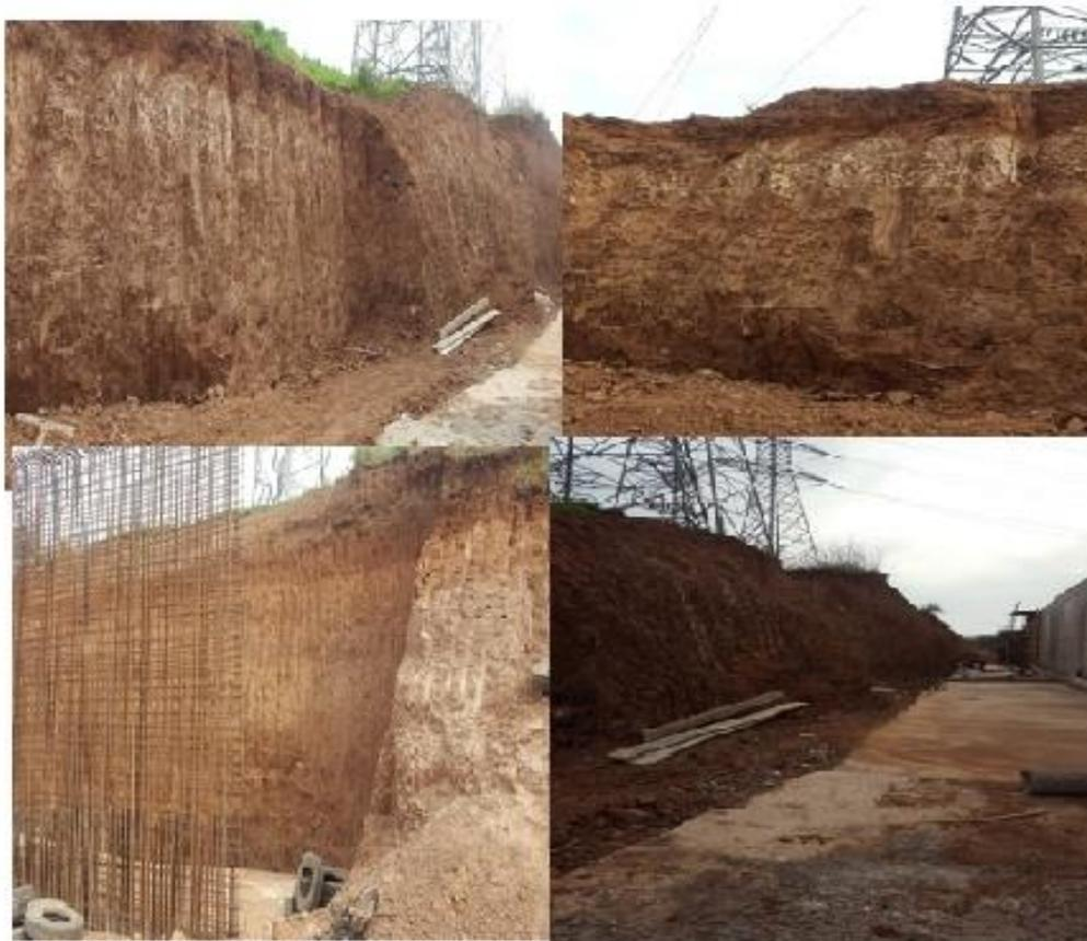
**Figure 4-2** Mur de soutènement poste benisaf2 en cour de construction lors du (terrassement, ferrailage, drainage) prise le 06/03/2019
