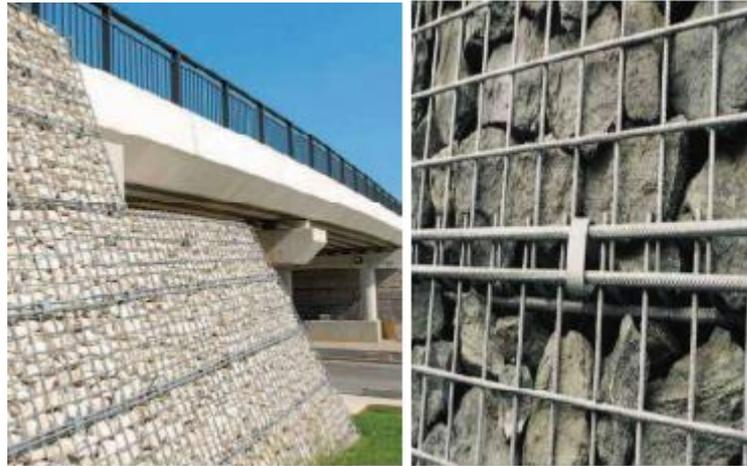
**Figure 3-7** Parement treillis soudé en acier (Ali, 2013)
