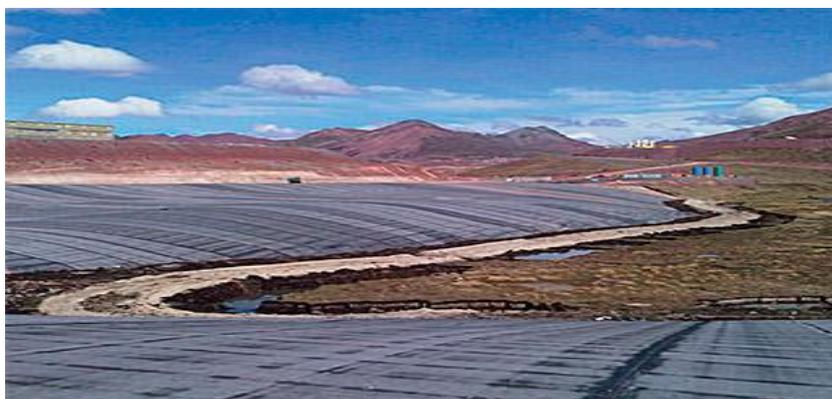
**Figure1-8** Une géomembrane bitumineuse (coletanche.com, s.d.)
