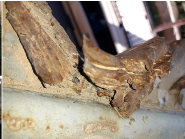
Photo.3.31 Petite déformation de la semelle.
