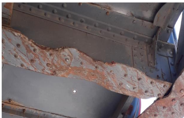
Photo.3.14 Poutrelle courante du milieu du pont.
