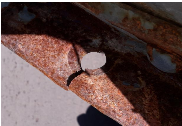
Photo.3.24 Trou de rivet sur semelle.
