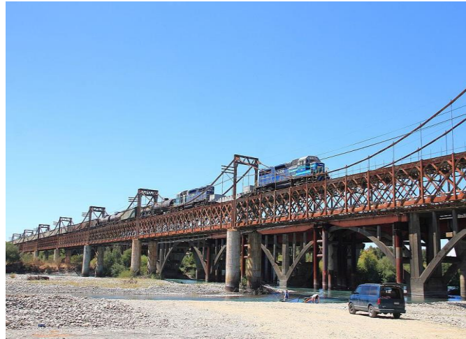
Photo.2.4 Pont sur le Río Toltén.(5)
