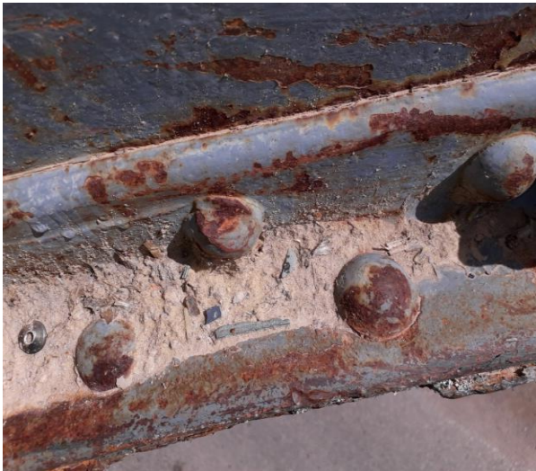
Photo.3.21 Rivets d'assemblage âme-semelle.
