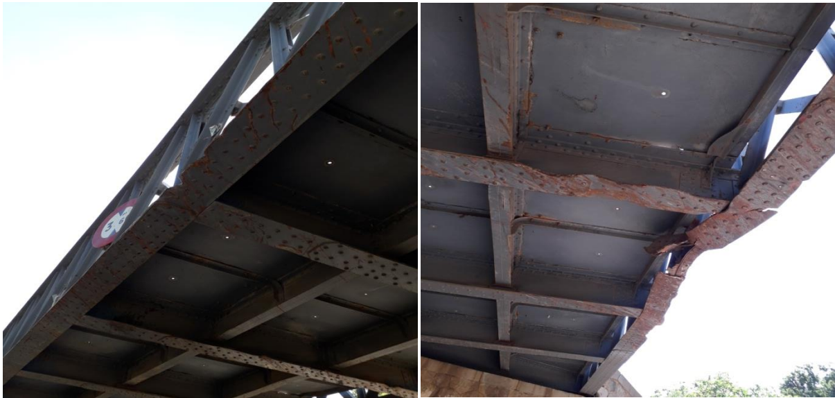
Photo.3.5 Vue de dessous du pont.
