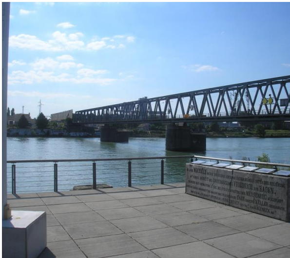
Photo2.2. Pont reconstruit en 1956.(5)
