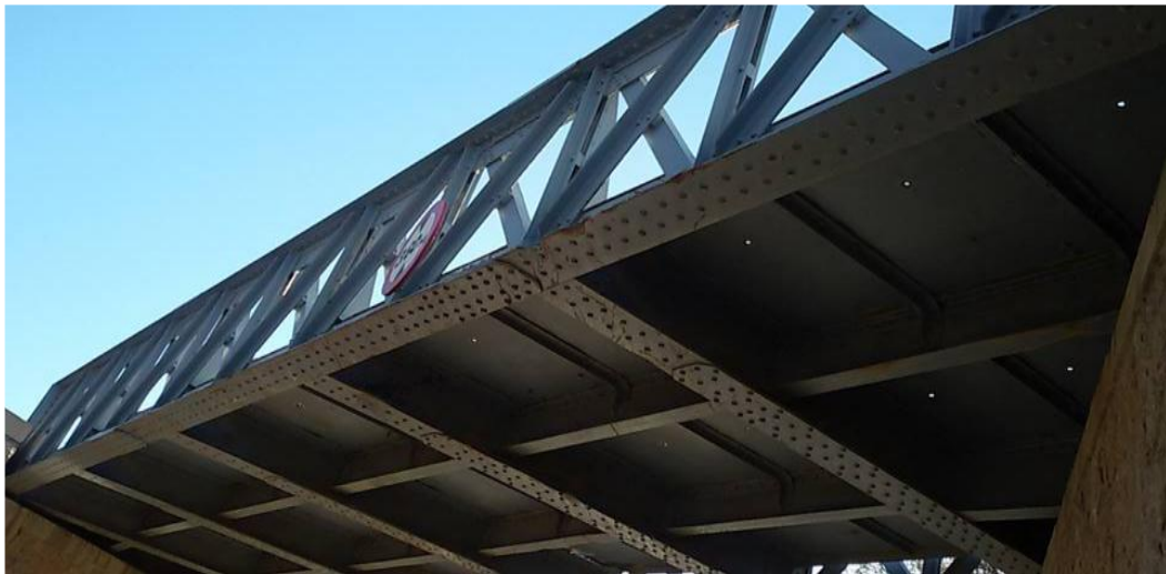
Photo.3.29 Poutre principale coté nord.
