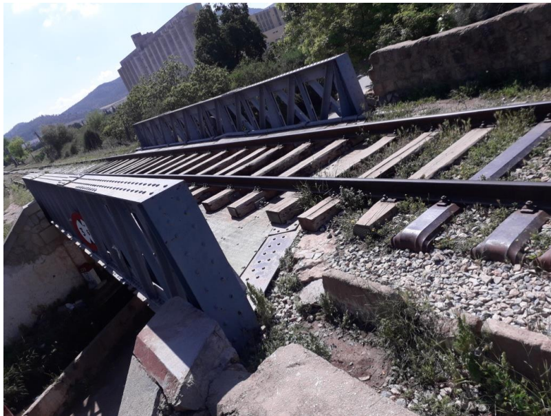
Photo.3.2 Pont biais vers Ouled Mimoun.
