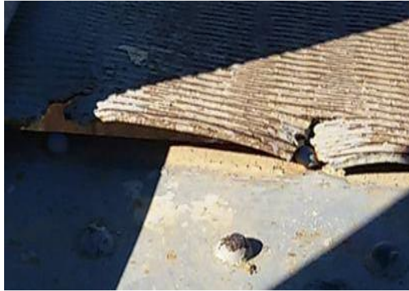
Photo.3.28 Déchirure de la tôle.
