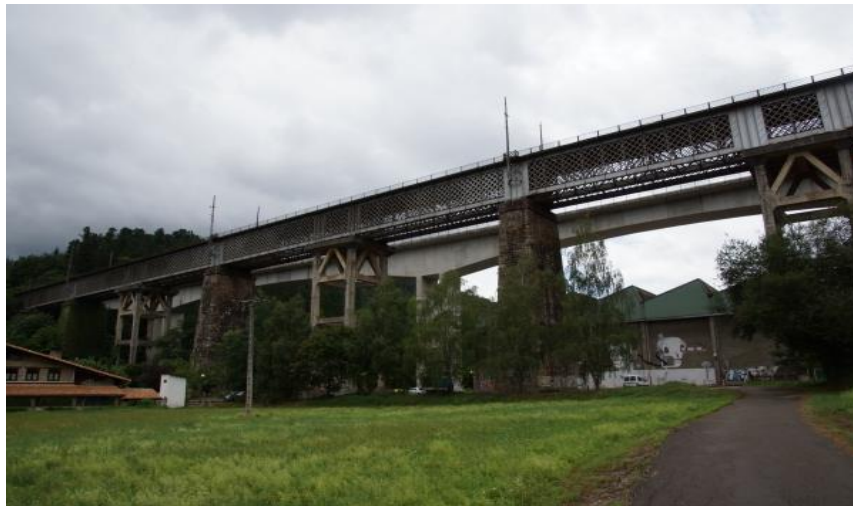
Photo.2.9 Viaduc d'Ormaiztegui (29 aout 2017).
