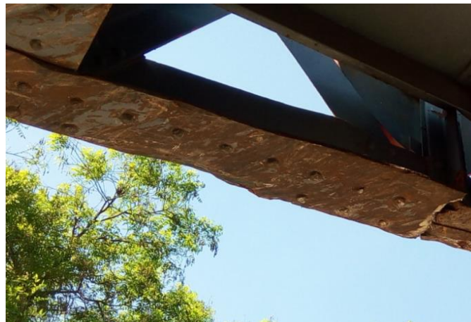
Photo.3.10 Poutre principale coté SEBDU vu d'en bas.
