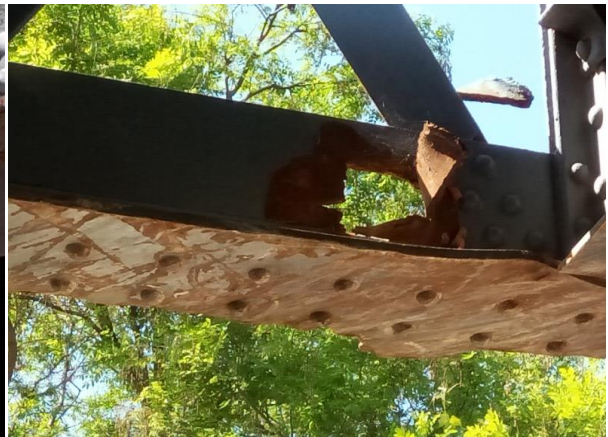
Photo.3.12 Trou d'ame vue de derrière.
