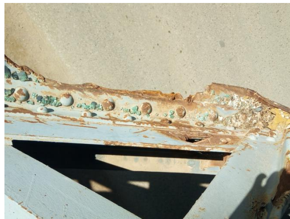
Photo.3.13 Semelle endommagée.
