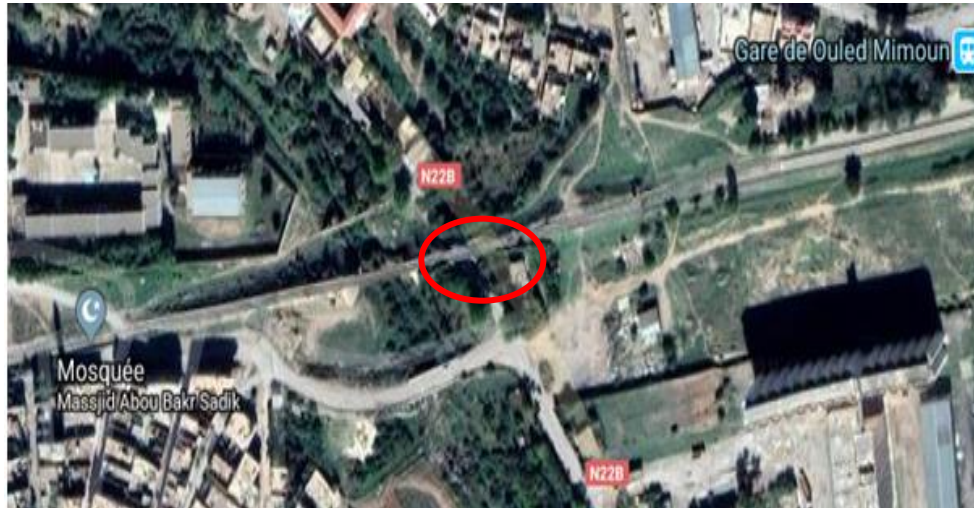
Photo.4.1 Vue de l'emplacement du pont (Google Maps).
