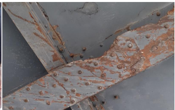
Photo.3.15 Intersection poutre-longeron.
