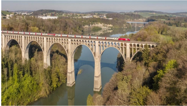
Photo.2.7 Viaduc de Grandfey réhabilité.
