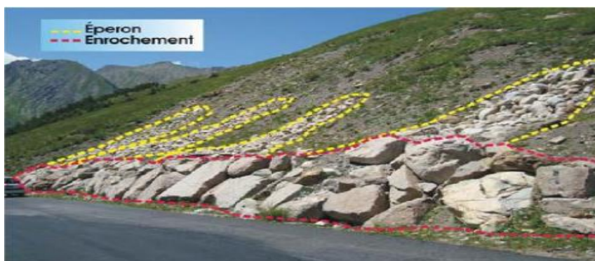
Figure 2.9: Stabilisation par enrochement.
