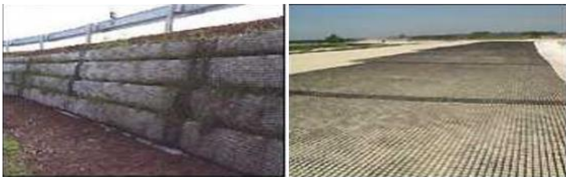
Figure 2.11: Renforcement par géo-synthétique
