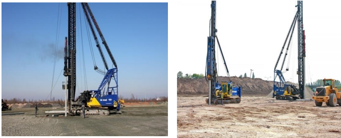
Figure 2.15 : Photos pendant la réalisation de pieux battus.
