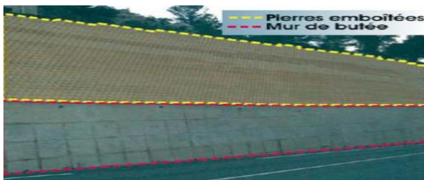
Figure 2.10: Mur en pierres sur mur en béton
