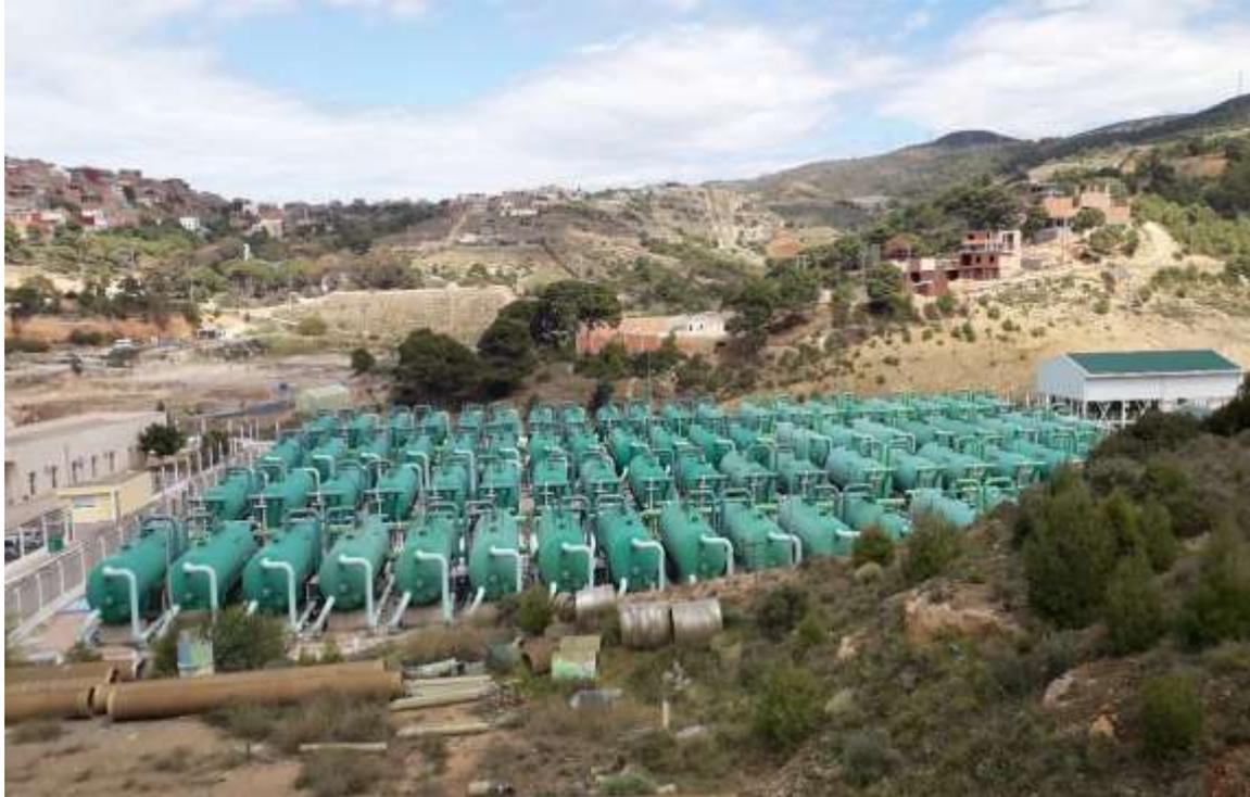
**Figure III. 4 :** Filtres à sable et anthracite.
