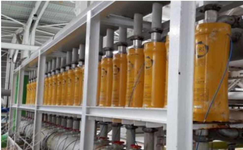
Figure III. 12 : Les ERIS (système de récupération de pression).
