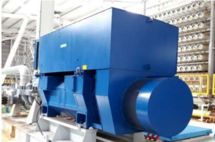
**Figure III. 9 :** Photo d'une pompe à haute pression.
