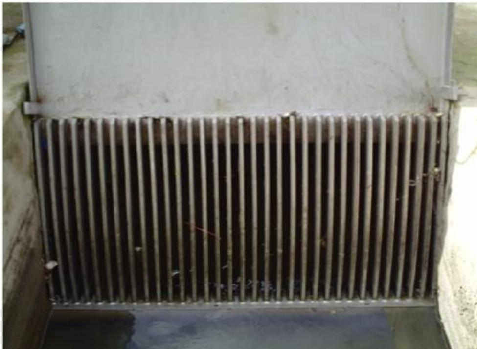
**Figure III.6 :** Photo de la grille fine manuelle de by-pass.
