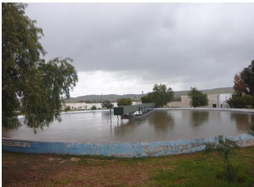
**Figure III.12 :** Photo de décanteur secondaire.
