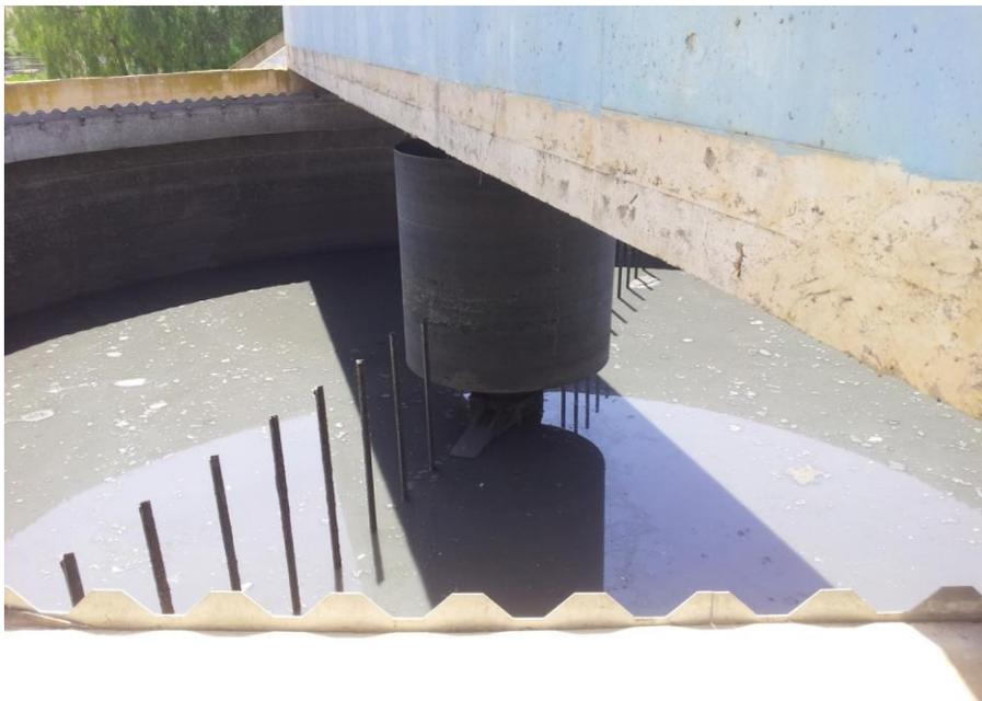
**Figure III.15** : Photo de l'épaississeur de boue.
