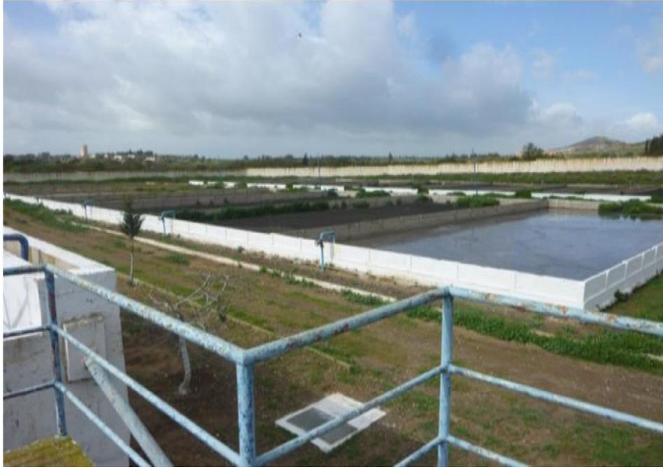
**Figure III.16** : Photos de lits de séchage.
