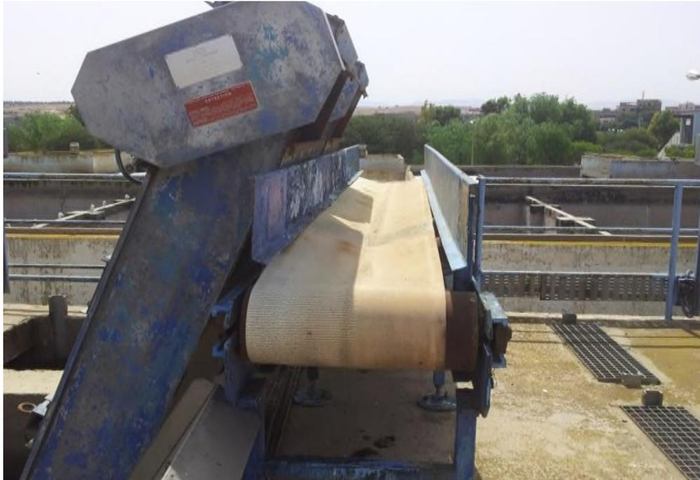
**Figure III.7 :** Photo de la bande de transport des refus de dégrillage.
