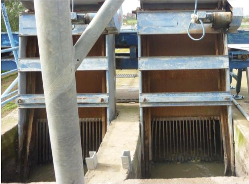
**Figure III.5 :** Photo de la grille fine mécanisée (02 unités).
