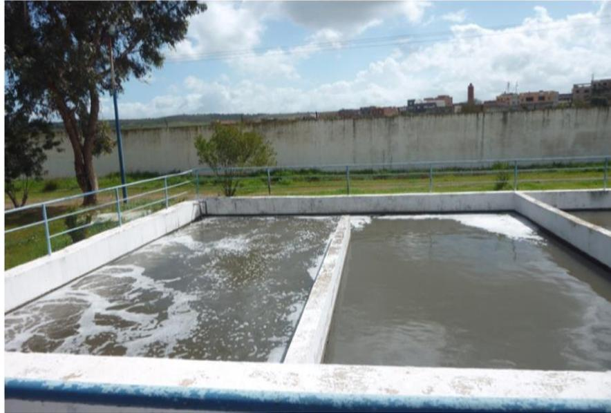
**Figure III.14** : Photo de bassin de chloration.
