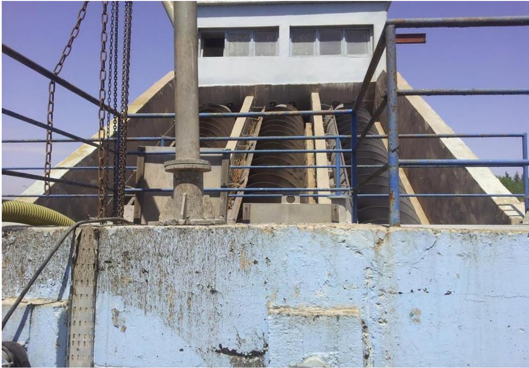
**Figure III.13** : Photo des vis de recirculation de boue.
