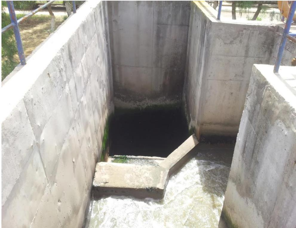
**Figure III.2:** Photo du déversoir d'orage.
