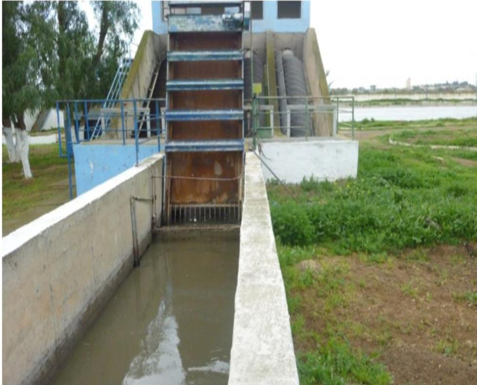
**Figure III.3 :** Photo de la grille grossière mécanisée.
