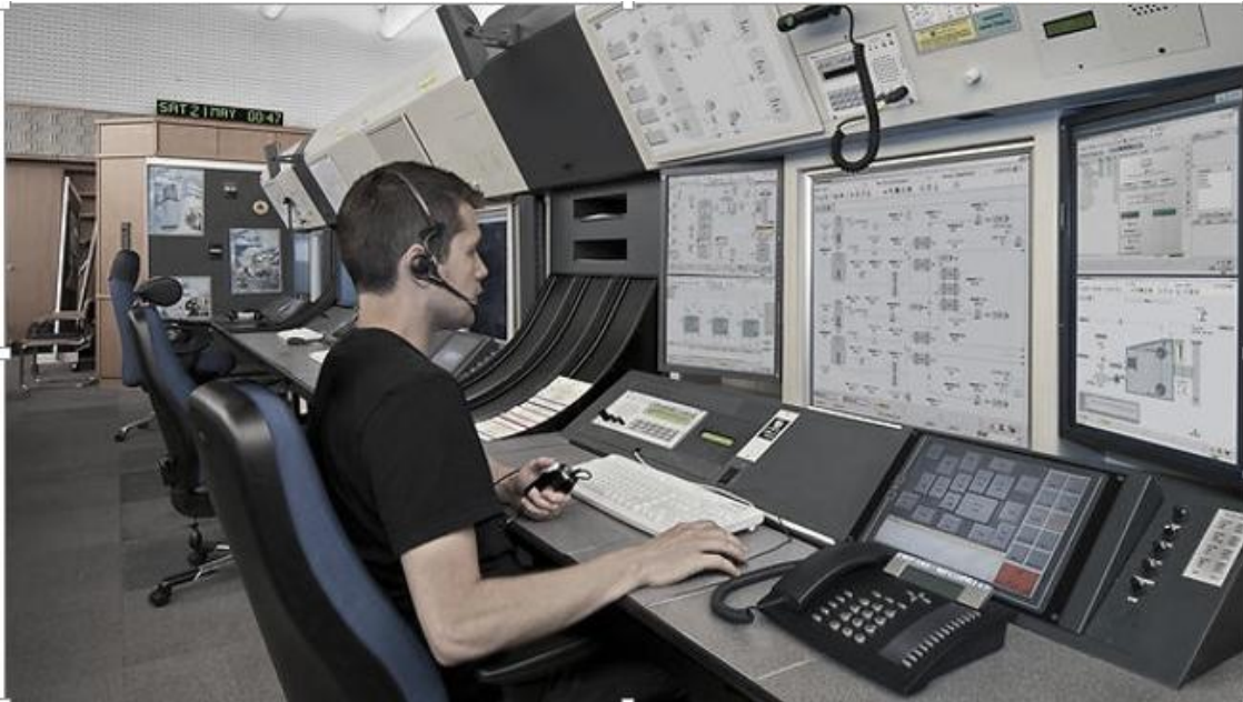
Figure 2.6 : système de contrôle distribué DCS [15].
