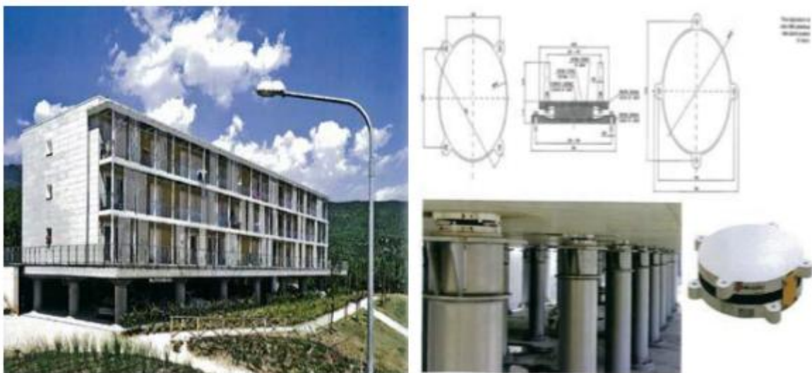
Figure VII.5 :Aquila bâtiments du quartier et le système de pendule de frottement utilisés [5].
