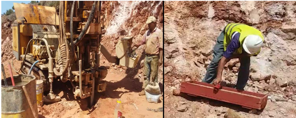
Figure 1-4 les essais in-situ
