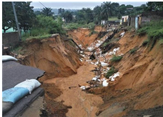
Figure 1.12 Un glissement de terrain causé par la présence d'érosion (l'érosion de kindele a MONT-NOGAFULA-DEPE, KINSHSA).
