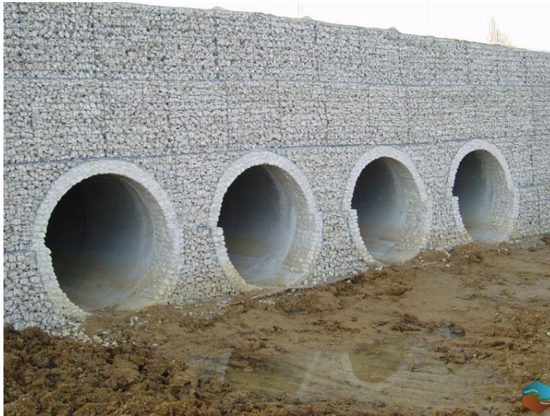
Figure 4.8: Buses en béton armée .
