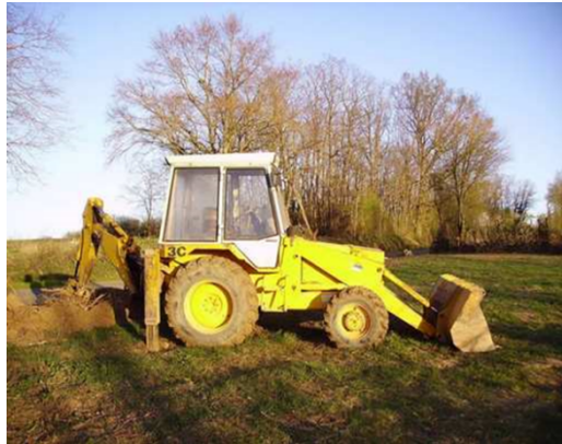
Figure 3.6 : Photo d'une pelleuse
