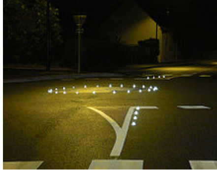
Figure 4.6 : Rond-point équipé d'une signalisation au sol rétro-réfléchissante.
