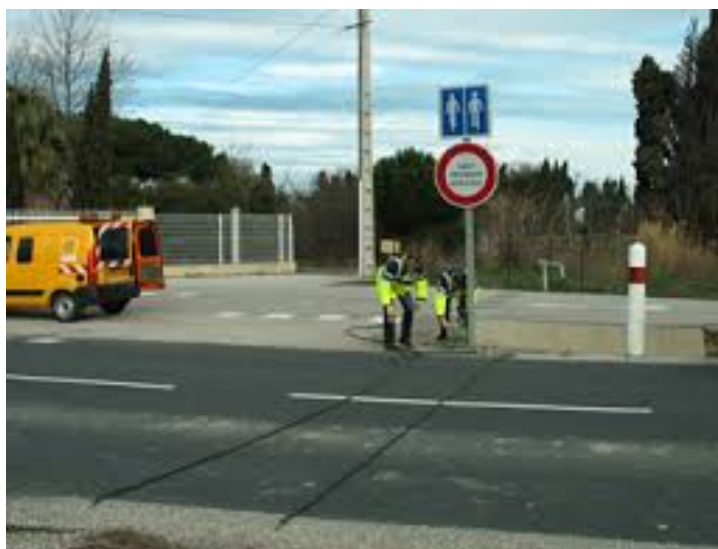
Figure 1.4 photo de pose d'un compteur de comptage, (département des pyrénées orientales )
