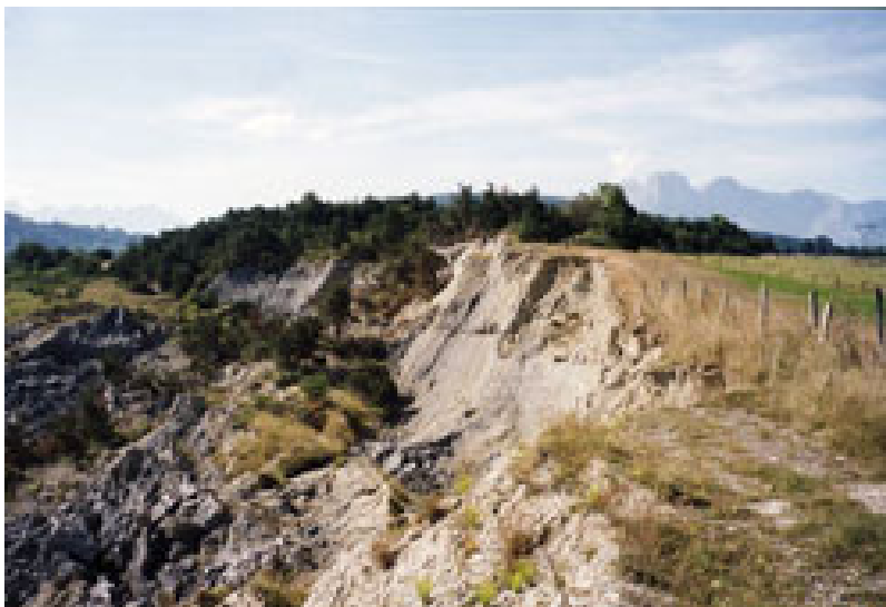
Photo II.1 : Glissement de terrain de l'Harmalière (actif) sur la commune de Sinard (Trièves, Isère) [8]
