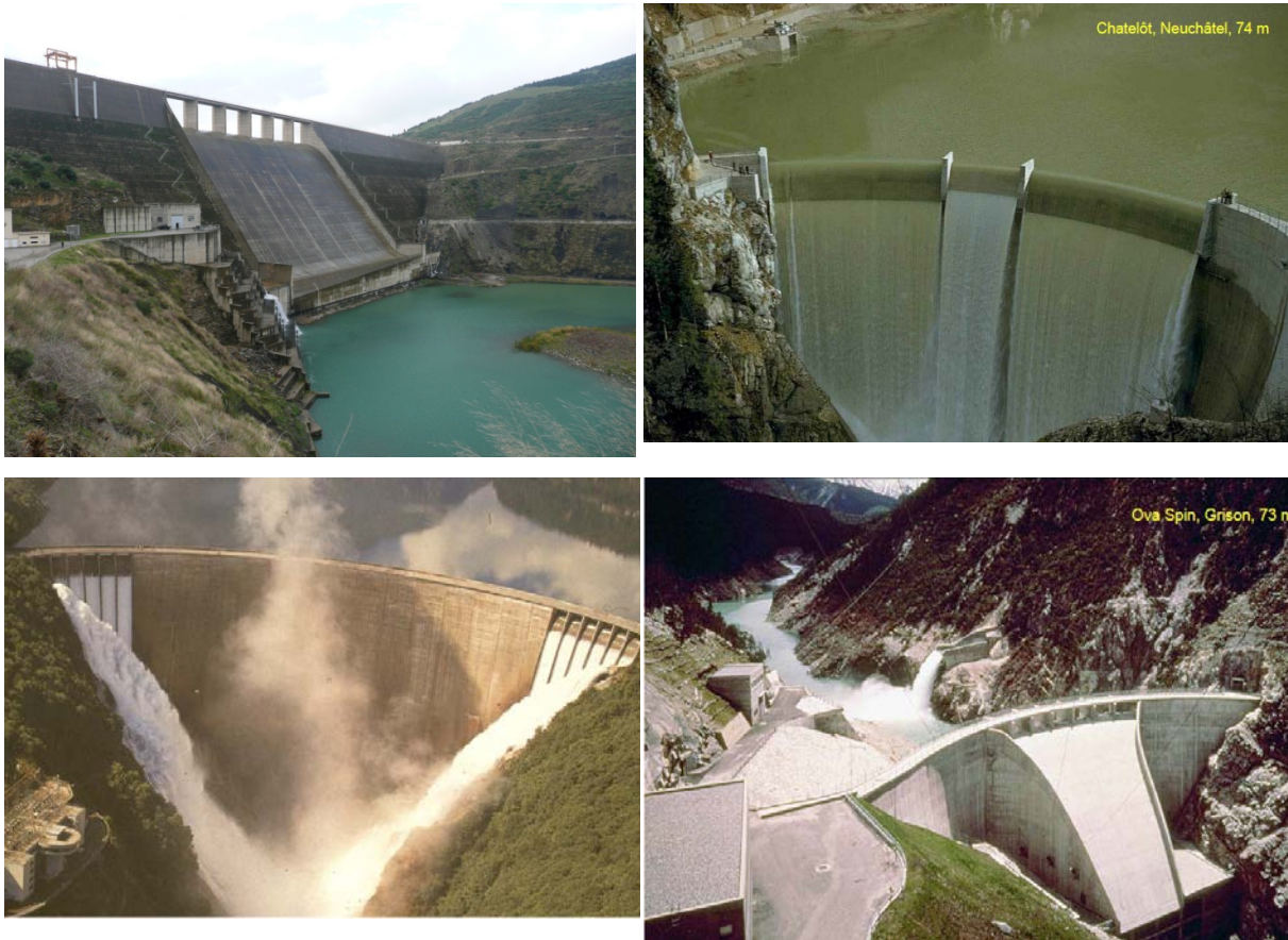
Photos III.03 : Evacuateurs de crues portés par les barrages [17]
