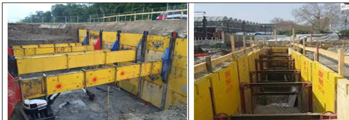
Photo I.01 : fouilles verticales avec blindage [5]
