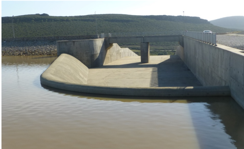
Photos III.01 : Evacuateur de crues à déversoir latéral [17]
