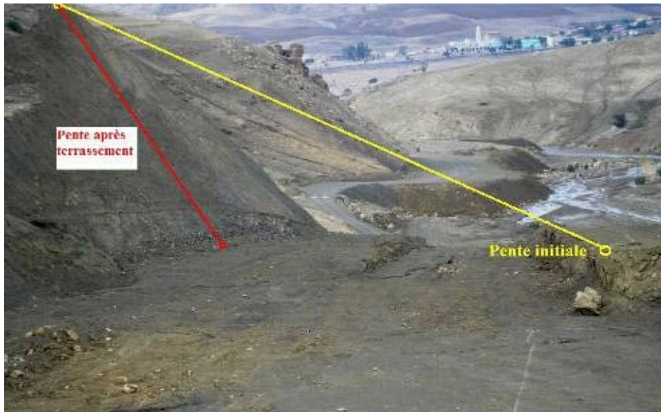
Photo IV.03 : Pente avant et après terrassement. [25]
