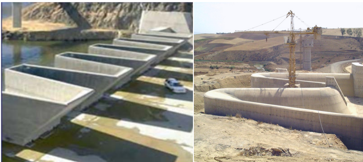
Photos III.09 : Evacuateurs à faible charge [23].
