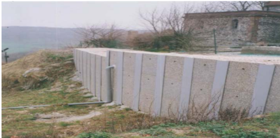
Photo II.3 : Paroi berlinoise (profilés métalliques) soutenant le cimetière marin de Varengé ville-sur-Mer. [6]
