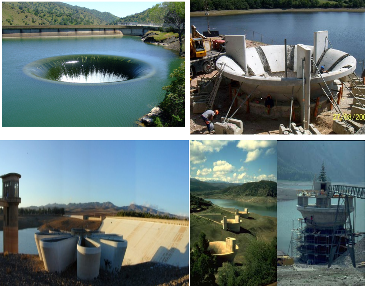
Photos III.04 : Evacuateurs de crues en puits [17]
