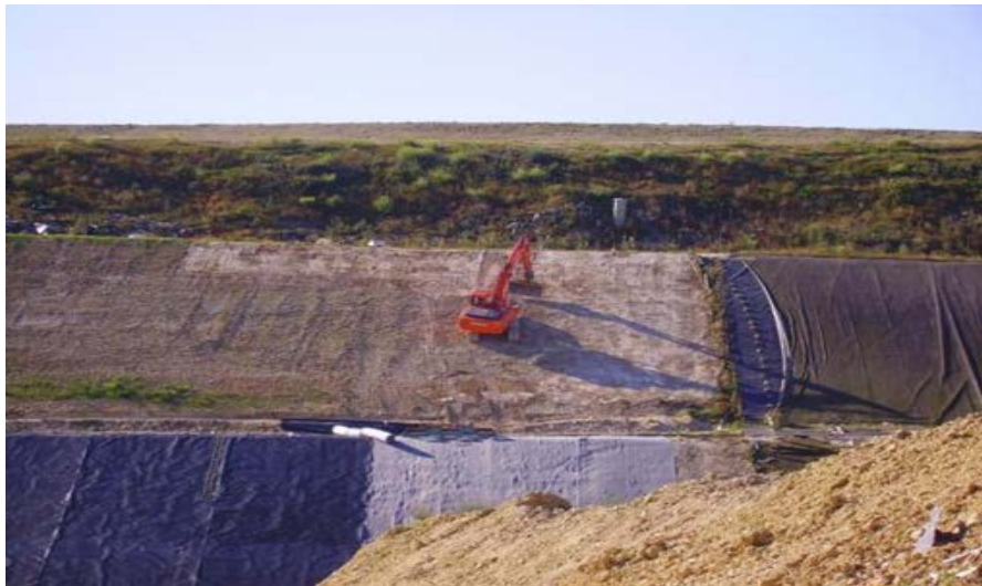
Photo I.02 : fouilles talutées [5]
