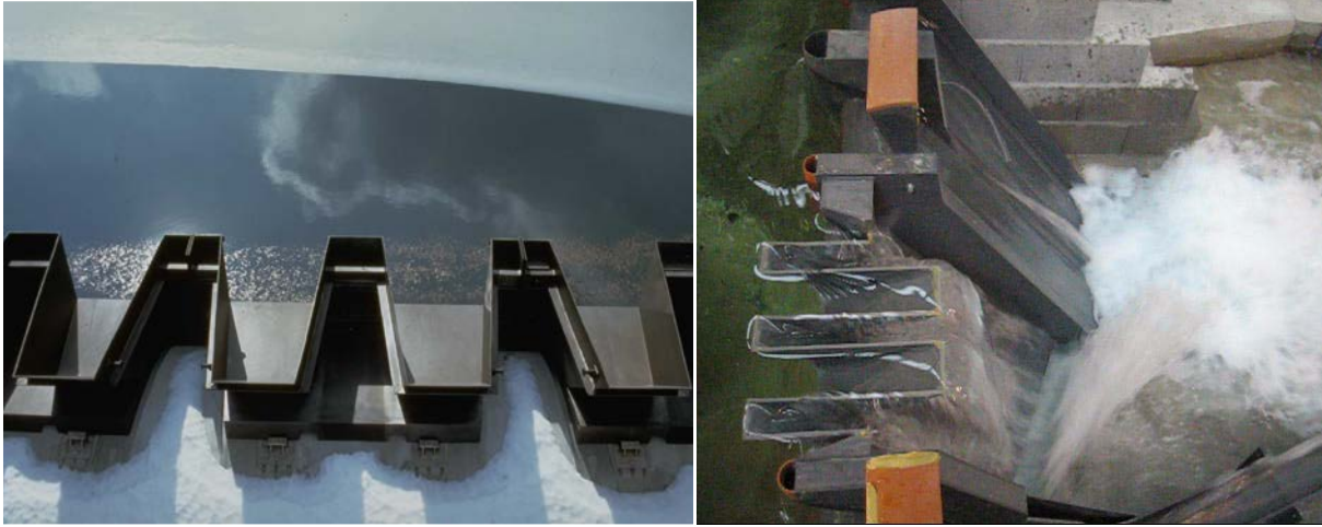
Photos III.08 : Evacuateurs à hausses fusibles [22]
