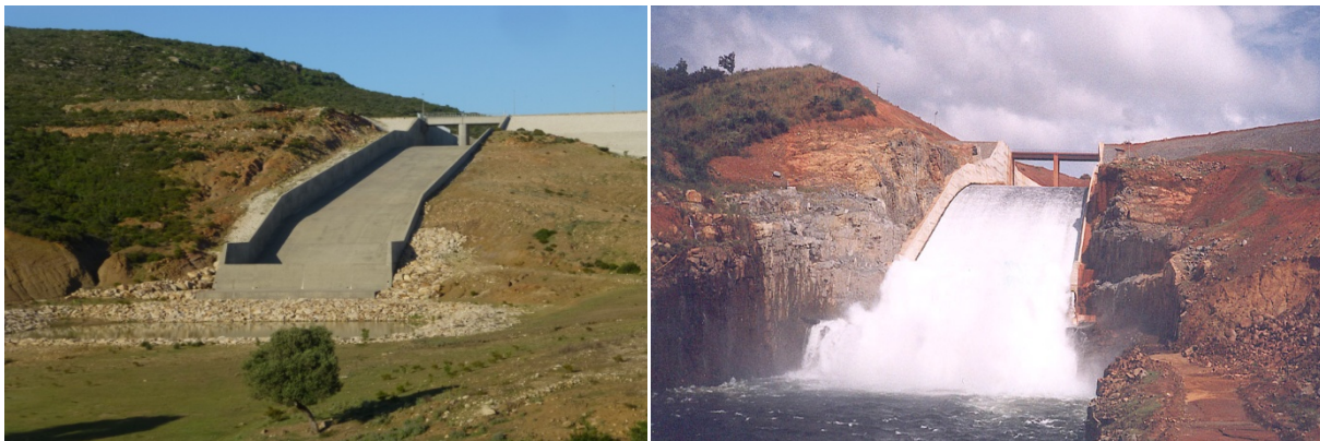
Photos III.2 : Evacuateurs de crues à déversoir frontal [17]
