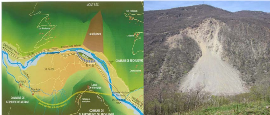
Photo II.4 : Exemple des Ruines de Séchilienne : 2 déviations de l'ex-RN91, merlon de protection, dérivation de la Romanche, travaux d'aménagement hydraulique, plan de secours, expropriations.
