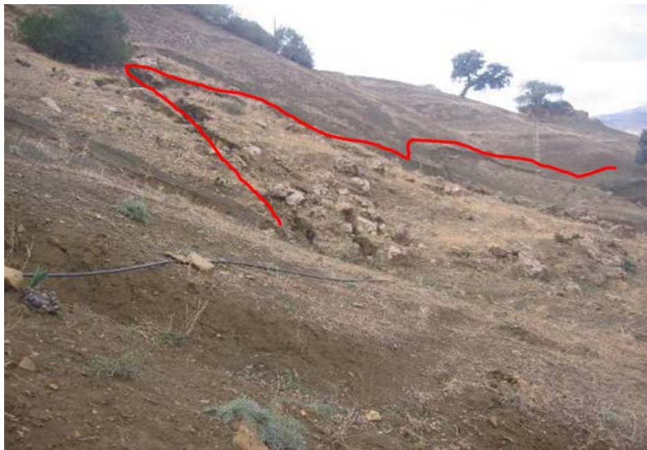
Photo IV.06 : Apparition des fissures dues à l'instabilité de la pente avec loupes de glissement [25]
