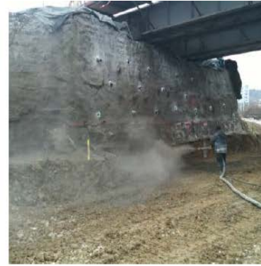
Figurell.11 : Principe du clouage et exemple de réalisation, image SIMPRO [11]
