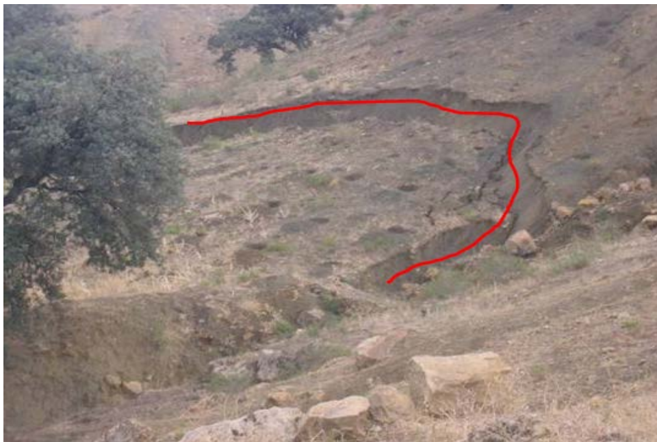
Photo IV.08 : Glissement d'un massif meuble et hétérogène. [25]
