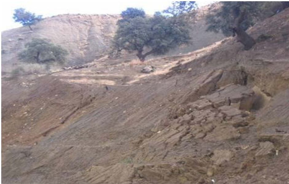
Photo IV.04 : Des glissements localisés [25]
