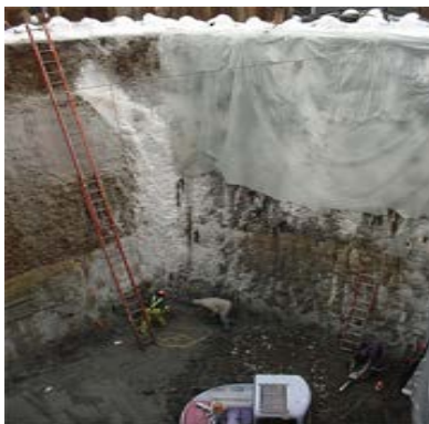
Figure 2 : Stabilisation par congélation.
