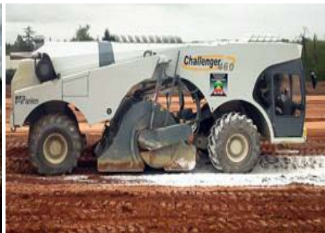
Figure 7 : Chantier de traitement d'un sol à la chaux. (AMOURA et MAAMERI, 2013).
