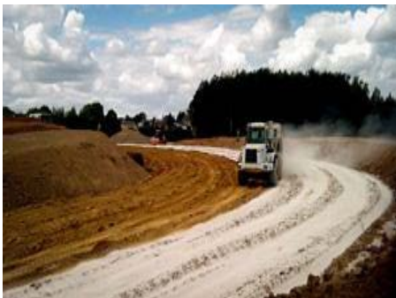
Figure 7 : Chantier de traitement d'un sol à la chaux. (AMOURA et MAAMERI, 2013).
