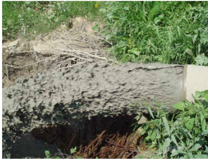
Photo I.5 : Opération de dragage au niveau de la retenue de Fergoug (2005)
