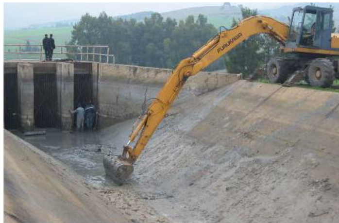
Photo I.1: Curage d'un canal par les moyens mécaniques [10]
