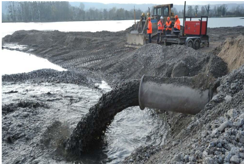
Photo I.3 : Immersion des sédiments de dragage du port de Rouen [13]
