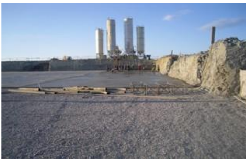
Photo 4.4 - Terrassement de l'assise du réservoir
