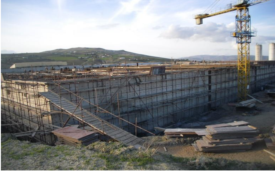
Photo 5.3 - Coffrage des voiles du réservoir
