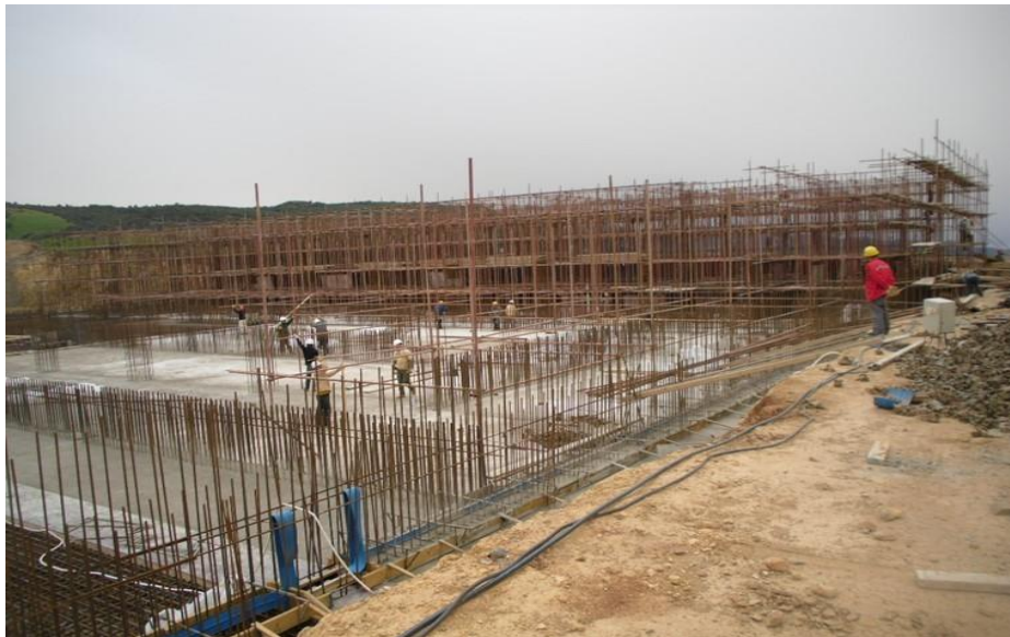
Photo 5.2 - Ferrailage des voiles du réservoir
