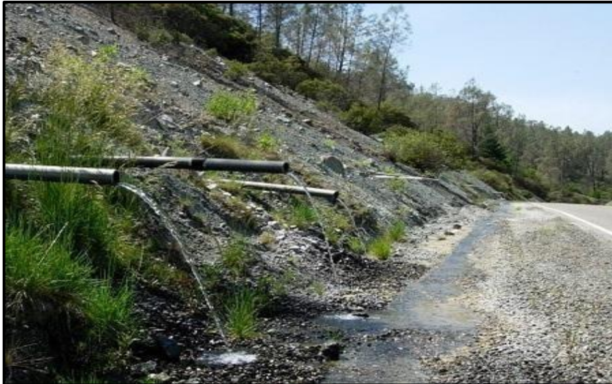
Figure 1.12 – Drainage de talus par barbacanes
