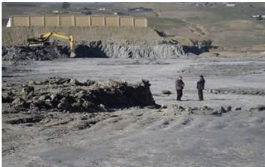
Photo 4.3 - Terrassements en grande masse
