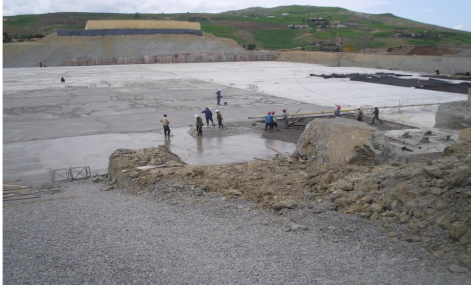
Photo 5.1 - Mise en place du béton de propreté
