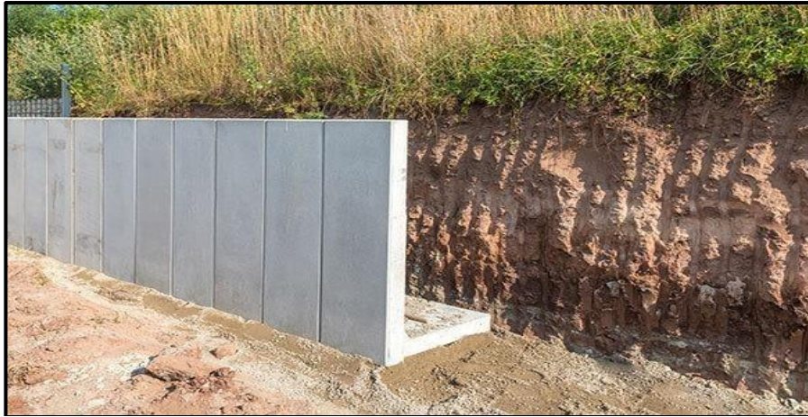
Figure 1.19 – Mur de soutènement
