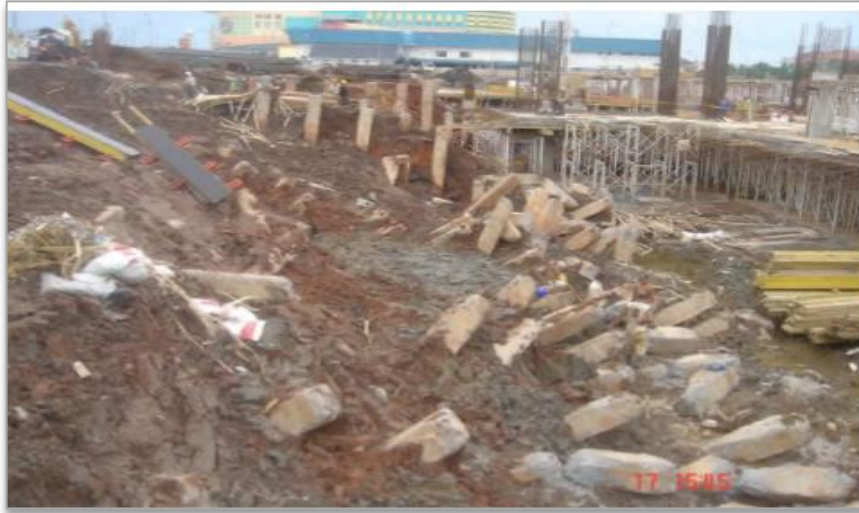
Figure 1.13 Excavation de tranchée ouverte à Jakarta (Indonésie) (Gouw, 2011)
