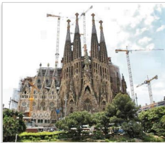
Figure 1. 9 Façade de la Sagrada Familia (Barcelone, Espagne). (Katzenbach & al, 2013)
