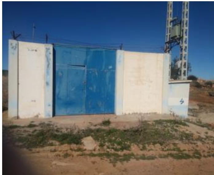
PhotoIV.3 : Le périmètre de protection immédiat pour le forage B2.
