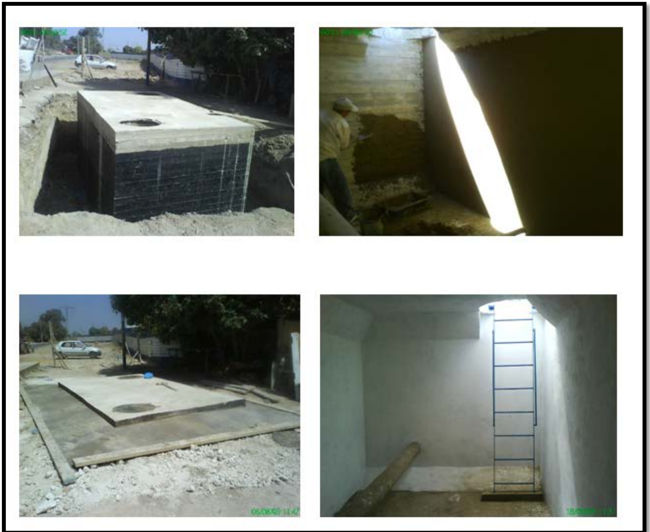
Figure IV.15: Etapes de travaux annexes (SEOR 2019).
