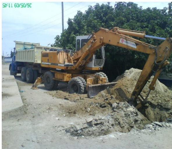
Figure IV.12: Démolition et terrassement (SEOR, 2019).
