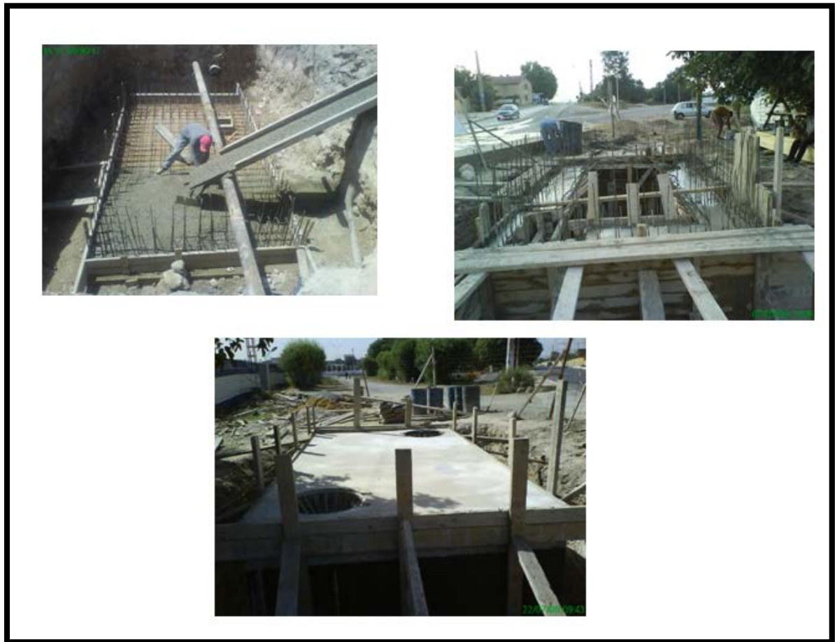
Figure IV.14: Etapes des Travaux génie civil (SEOR, 2019).
