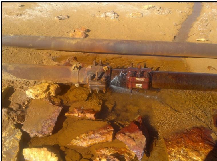
*Photo. 3 : Percement ligne 6 (Puits TFT 614).*
