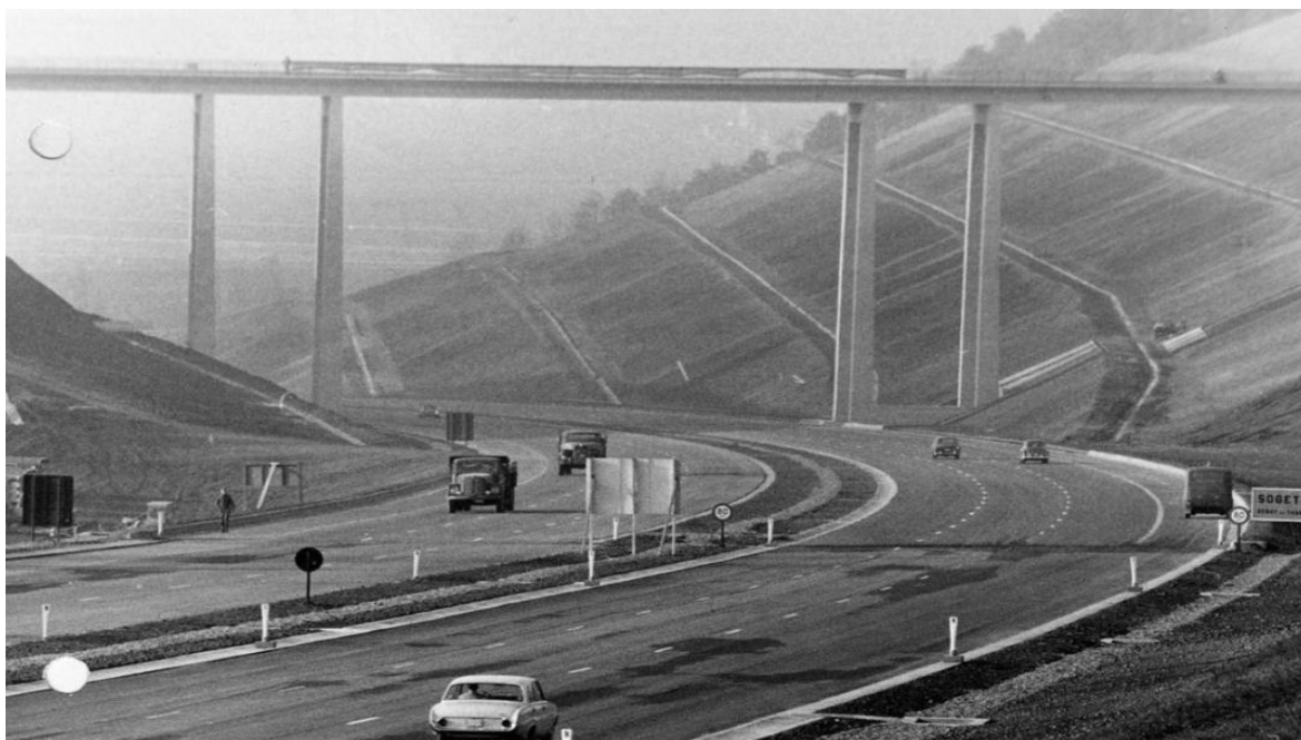
Figure I.3. Pont préfabriqué en Belgique.
