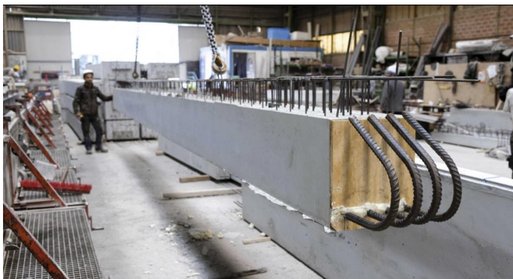
Figure I.4. Usine de préfabrication la Farge.
