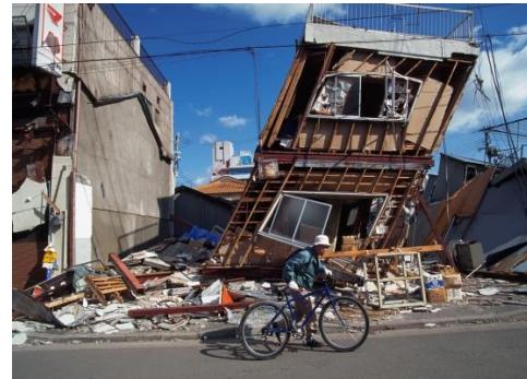
b) un immeuble effondré par le séisme de Kobe 1995
