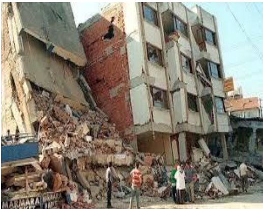
c) Deux bâtiments après le séisme d'Izmit 1999
