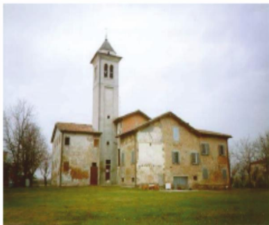
(a) Vue Générale
