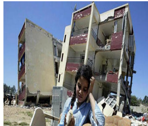
d) un bâtiment endommagé par le séisme de Boumerdes 2003
