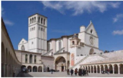
(a) Vue Générale
