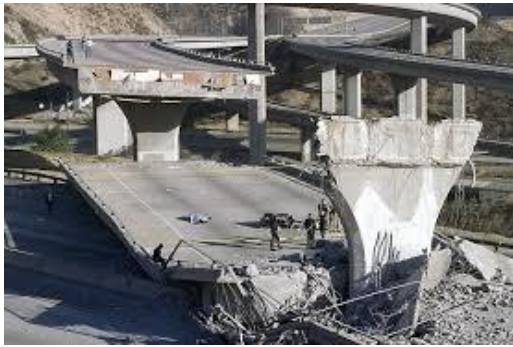
a) Un pont détruit par le séisme de de Northridge 1994
