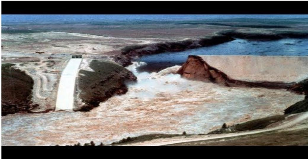
**Figure 1.9: Rupture du barrage Teton, USA**
