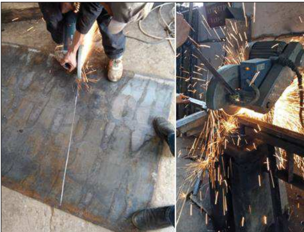
Fig. 3.2. Découpage avec tronçonneuse
