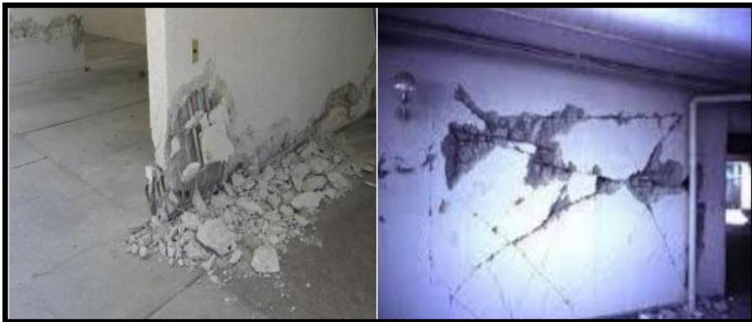
Figure 1. 3 : Dégâts subis par les voiles (3).
