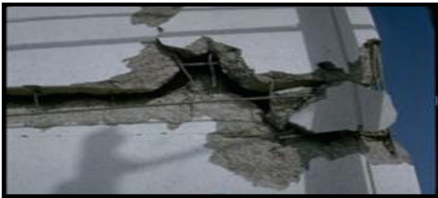
**Figure 1. 12 :** Cisaillement d'un voile faiblement armé (Séisme d'Anchorage, 1964)
