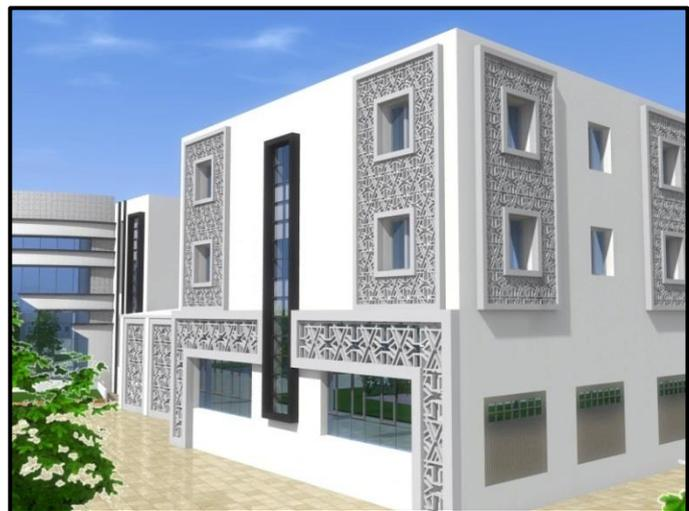
**Figure 191, 192**: le moucharabié utilisé au projet
