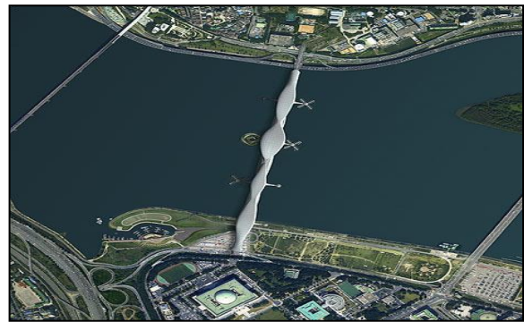
Figure 16 : Situation du Paik Nam June Media bridge, Séoul, Corée du Sud.
