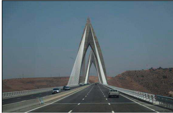
Figure 5 : Pont routier, Maroc
