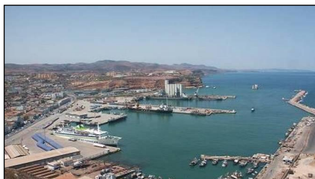
Figure 50 : Le port de GHAZAOUET
