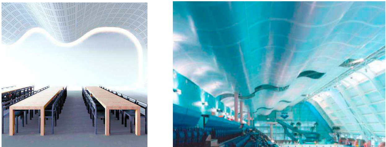
Figure 113 : Faux plafond courbé
