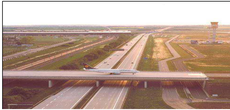
Figure 8 : Pont pour avions « aéroport en Allemagne
