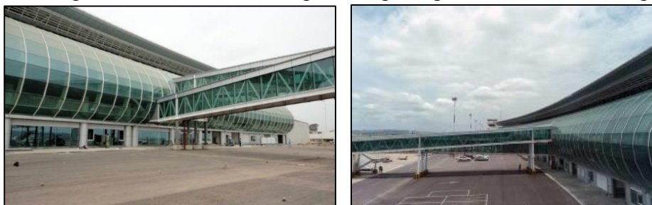
Figure 95 : les passerelles télescopiques
