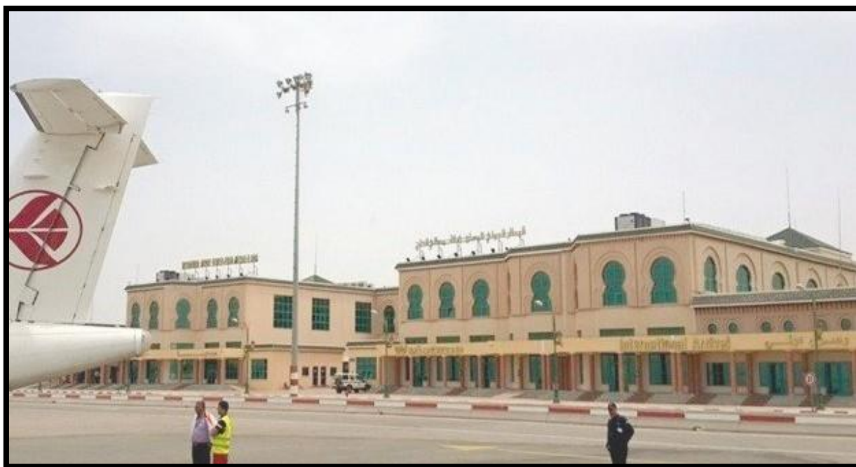
Figure 59 : Aéroport « Messali Hadj » de Tlemcen
