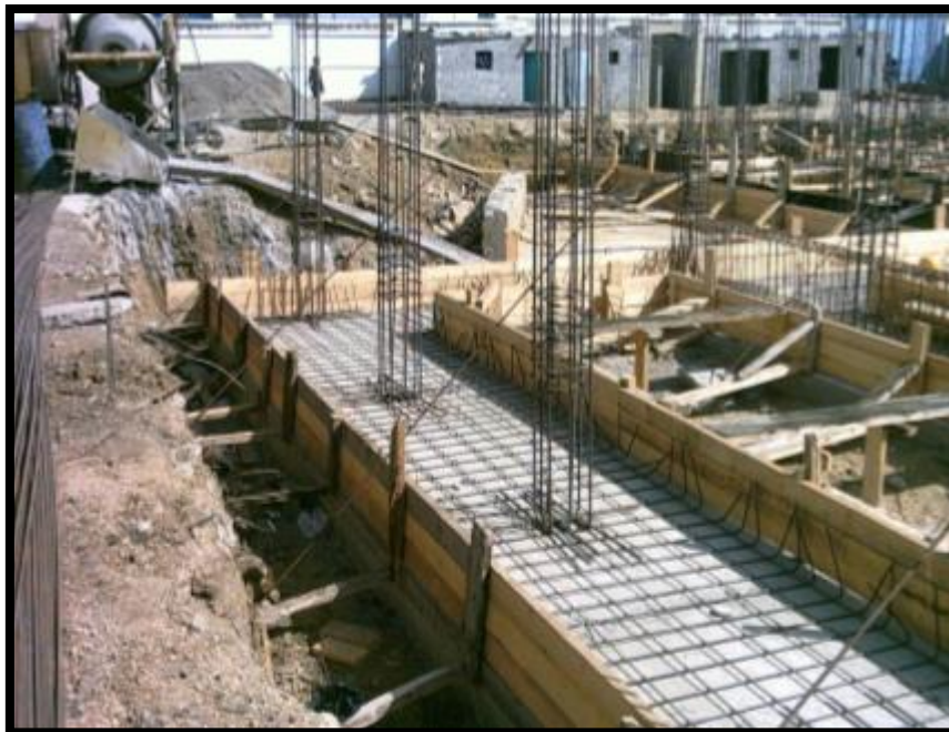
Figure 107 :exemple d'une semelle filante
