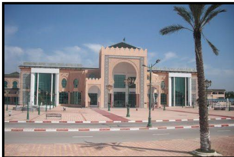
Figure 64 : Vue sur l'aérogare passager
