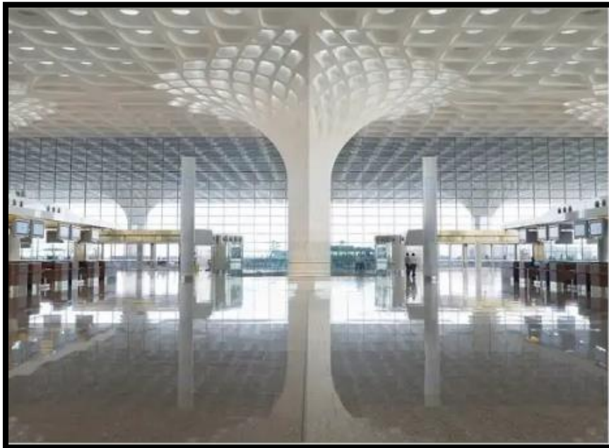
Figure 42 : Nouvel aéroport de Mumbai Chhatrapati Shivaji Les colonnes aux allures de champignons blancs sont habillées de plaques préfabriquées en béton armé de fibres de verre 40 .
