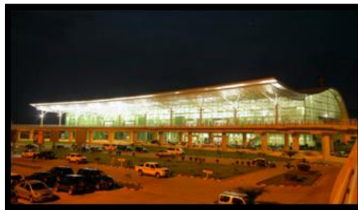
Figure 94 : façade de l'aéroport
