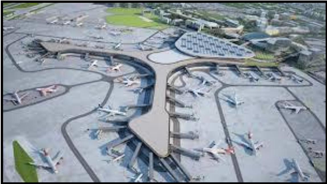
Figure 11 : La toiture de l'aéroport de Mumbai Chhatrapati Shivaji
