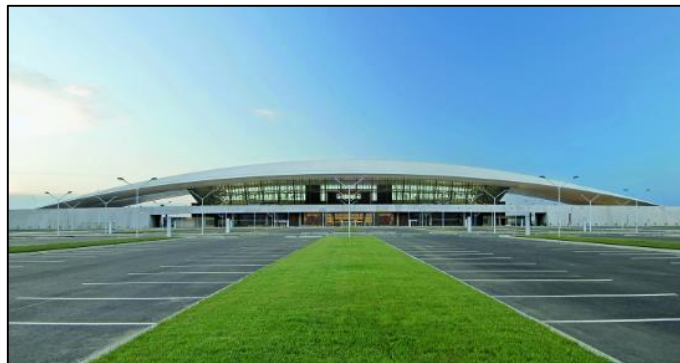
Figure 87 : façade de l'aéroport
