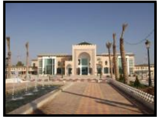
Figure 61 : Aéroport « Messali Hadj » de Tlemcen
