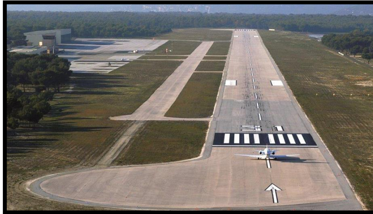
Figure 69 : vue sur un aérodrome
