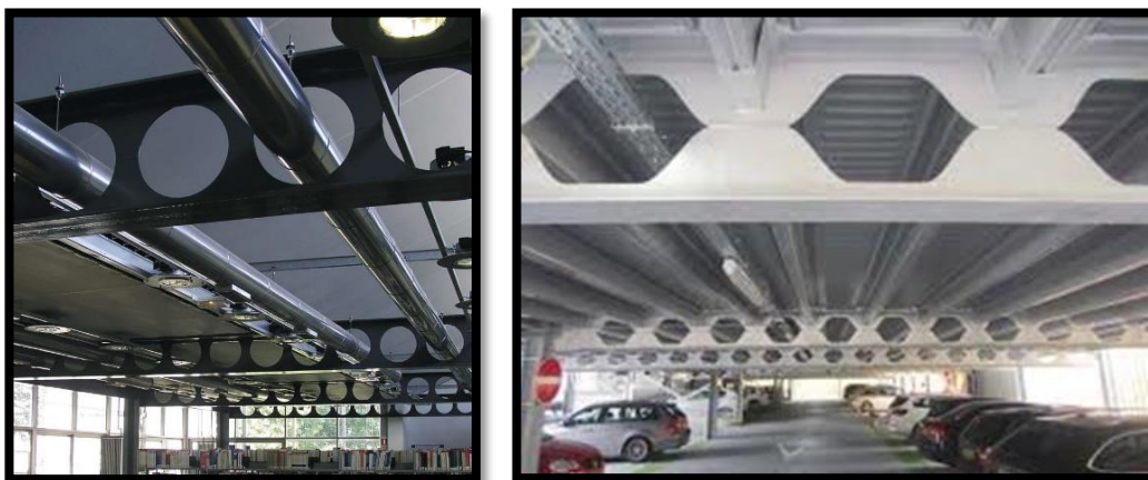
Figure 109 :poutre alvéolaire
