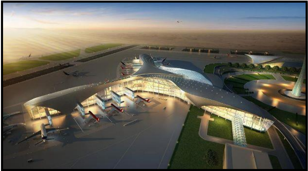
Figure 7: Aéroport international du Niger
