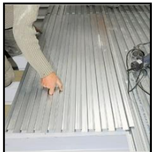
Les plaques sont soigneusement aboutées pour assurer une bonne continuité et éviter que du béton ne coule entre les raccords lors du coulage de la dalle.
