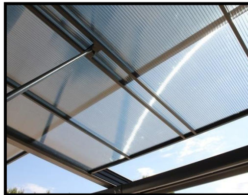
Figure 141 : Toit ouvrant coulissant
