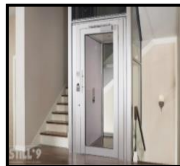
Figure 162 : Ascenseurs électriques dans un escalier en U
