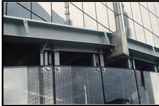
Figure 147: Paroi avec des lames de verre
