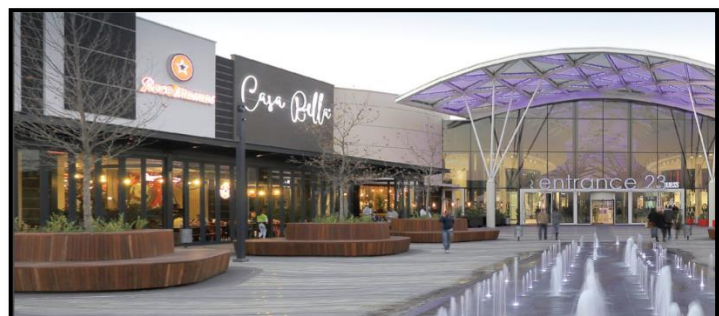
Figure 97 : façade principale du Mall
