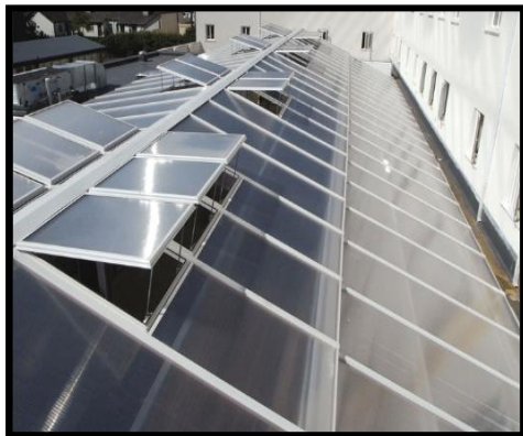
Figure 140 : Verrière avec fenêtres de toit
