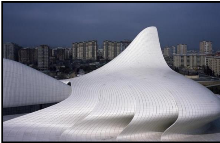
Figure 137: Toiture en polyoléfine thermoplastique (centre culturelle Azerbaïdjan)
