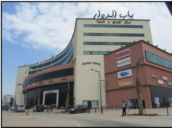
Figure 79 : les façades du centre de BAB EZZOUAR
