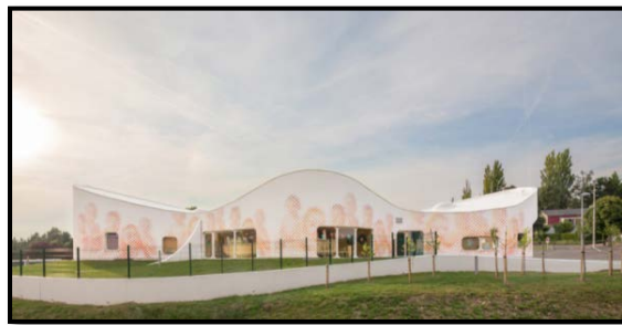
Figure 118 : exemple de toiture en coque source : www.pinterest.com
