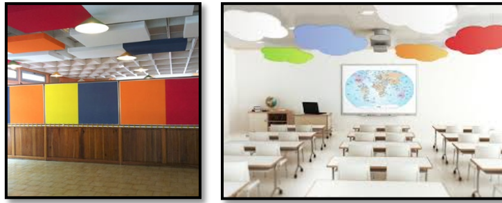
Figure 127 : Exemples des faux plafonds similaires à celle de notre projet Source : http://www.tdacoustic.com/creches-et-haltes-garderie.html
