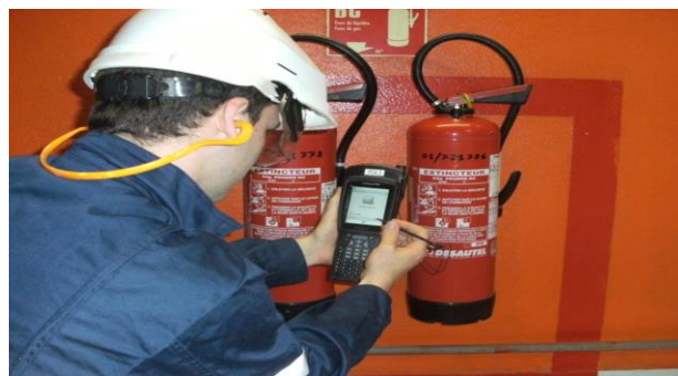
Figure 153: Gestion d'extincteurs et ARI par RFID
