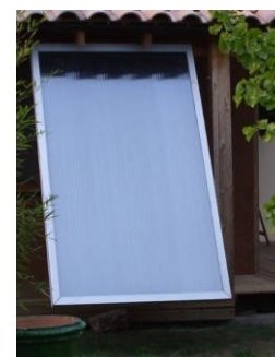
Figure 158: Un panneau thermique auto construit monté en façade
