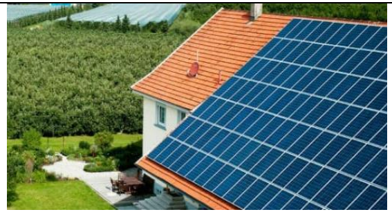
Figure 159: Toiture couverte en panneaux solaire photovoltaïques
