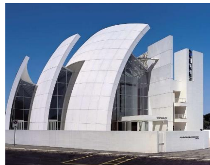
Figure 76. Exemple d'une construction en béton autonettoyant (source : https://www.science-et-vie.com/archives/les-5-secteurs-cles-les-materiaux-un-fabuleux-jeu-de-construction-13925 )
