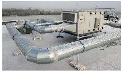
Figure 123. Exemple du système VMC (Source : https://www.lemoniteur.fr/article/le-dtu-prend-en-compte-la-vmc-double-flux.1958394 )
