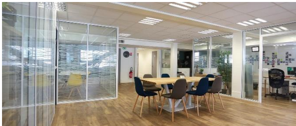
Figure 85. Exemple de cloisons amovibles vitrées dans des bureaux (source : https://www.arteamenagements.fr/cloisons-amovibles-de-bureaux/cloisons-vitrees/ )
