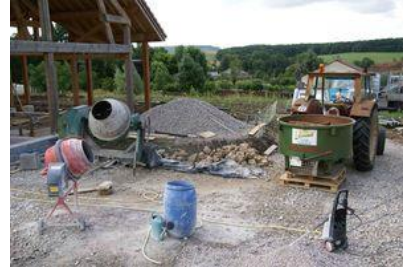
Figure 92. les travaux dans un chantier (source : https://canplast.ch/traitement-eaux/industries-ateliers-chantiers/traitement-des-eaux-de-chantiers/ )
