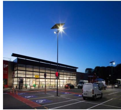
Figure 108. Lampadaire solaire (all in one) dans espace de stationnement (source : https://www.usinenouvelle.com/expo/lampadaire-solaire-pour-parking-p72554273.html )
