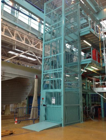
Figure 42. Exemple d'un monte-charge (source : https://www.hamon.fr/produit/monte-charge )
