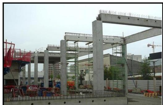
Figure 90 : structure poteau -poutre
