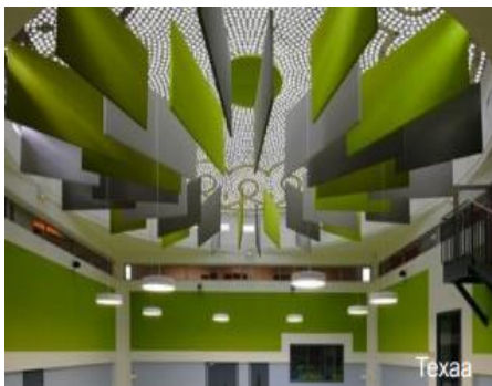
Figure 139:Les baffles acoustiques
