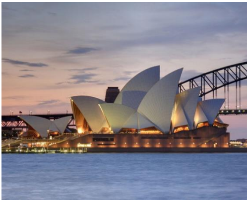
Figure 6: l'opéra de Sidney les coques est en béton armé recouvert de tuiles miroitantes en céramique.
