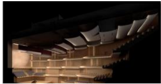
Figure 144:réflecteur acoustique en plastique ETFE
