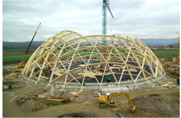
Figure 18: construction tridimensionnelle en bois
