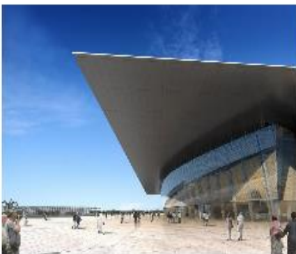
Vue sur la façade sud
