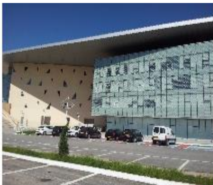
Vue sur la façade nord-est
