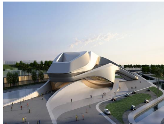
Figure 5:le grand théâtre de rabat les coque en beton arme en forme libre
