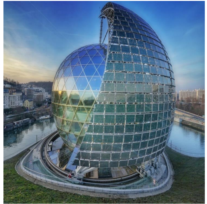
Figure 79: Panneaux photovoltaïques d auditorium du sein musical
