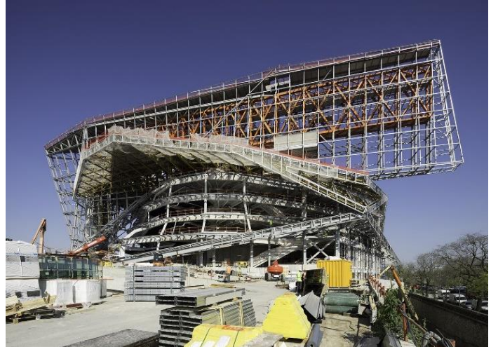
Figure 8:structure métallique dans la philharmonie de paris
