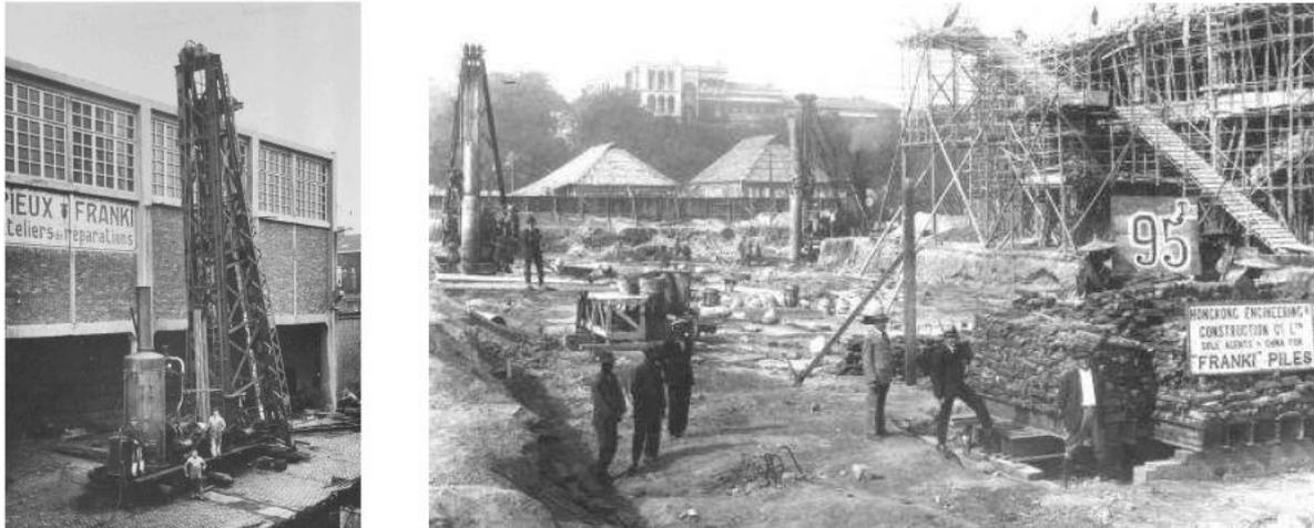
**Figure 1.8** : Sonnette à vapeur et essai de chargement (société Franki à Liège vers 1912)[6]
