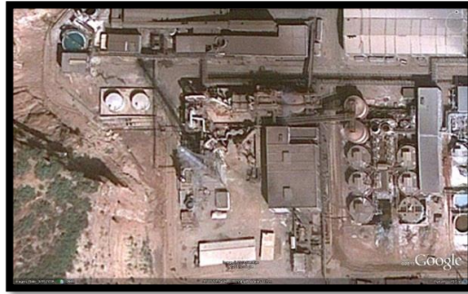
Figure39. Vue aérienne de l'unité industrielle.
