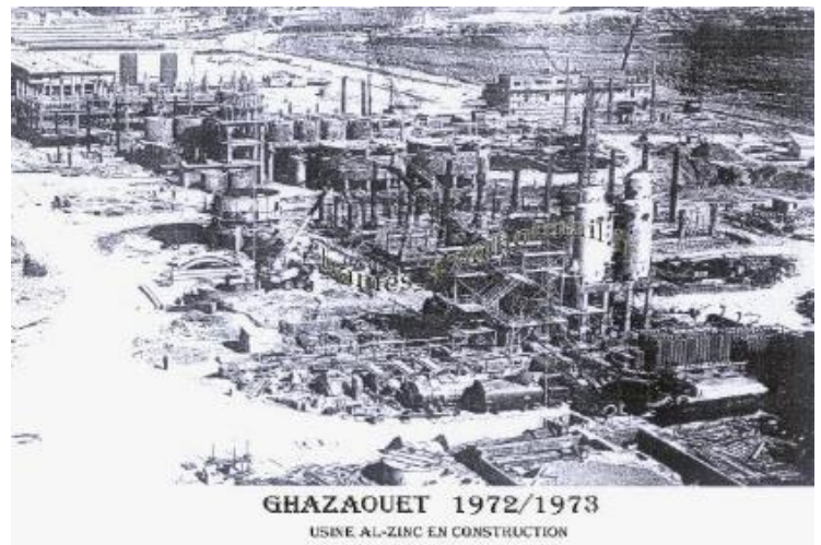
Figure45. Usine de Ghazaouet en construction
