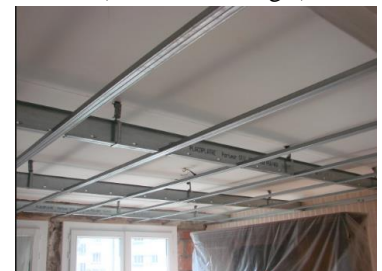
Figure 106. Installation des rails pour fond plafond suspendu. (Source : Plafond placo.com)
