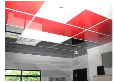
Figure 107. Le faux plafond suspendu. (Source : Plafond placo.com)
