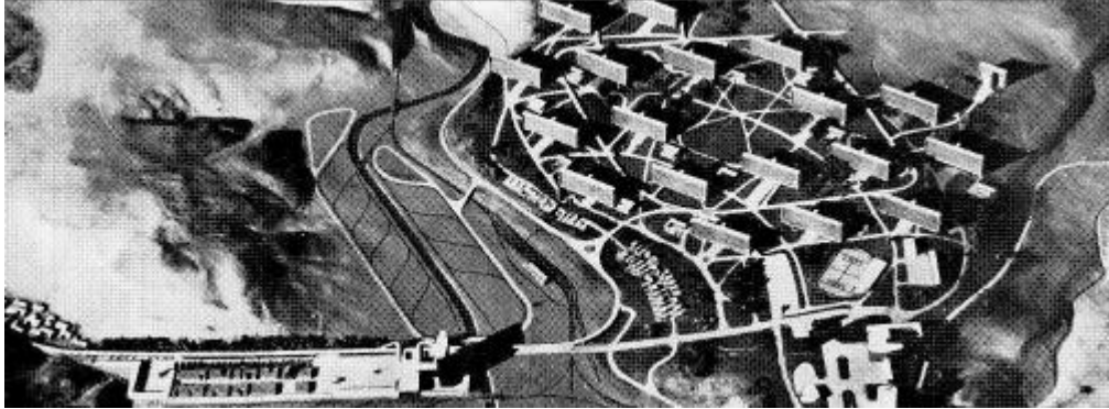
Figure 24. Les 18 immeubles d'habitation
