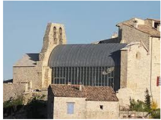
Figure 50 vue générale sr l'église saint Christophe après réhabilitation
