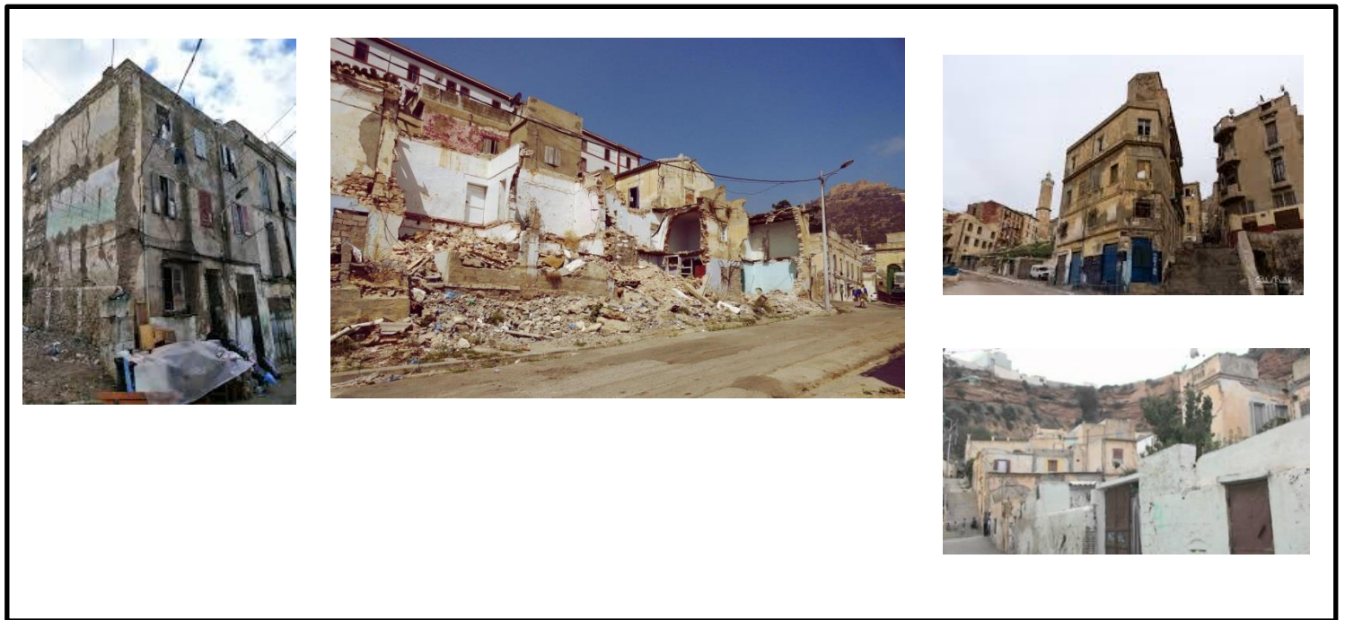
Figure 22 état du bâti dans le quartier de sidi el Houari
