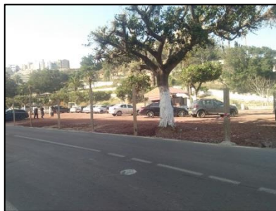
Figure 73 Travaux de réhabilitation place de la république 14/02/2019
