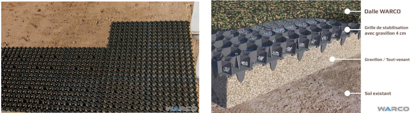
Figure 135 pose d'une grille de stabilisation
