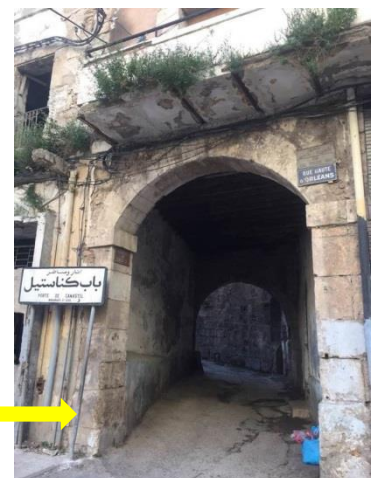
Figure 62 entrée porte Canastel
