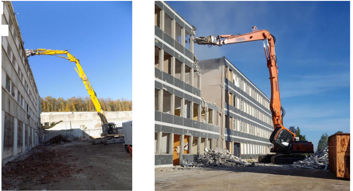
Figure 131 exemple démolition par découpage partiel d'une structure
