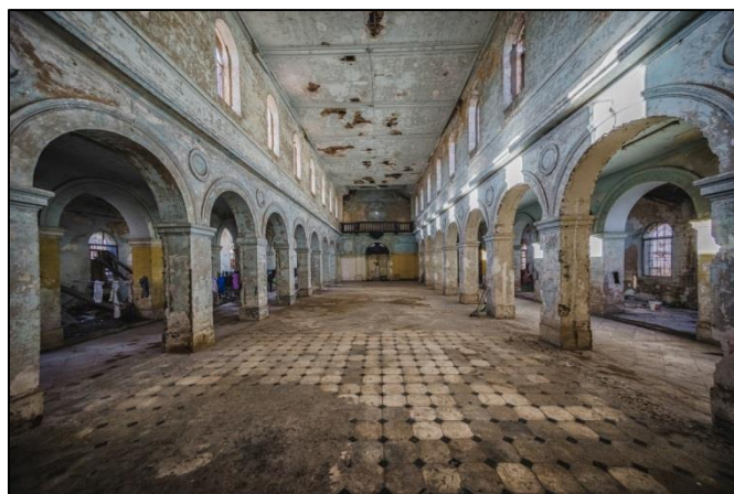
Figure 96 intérieur de l'église 2012
