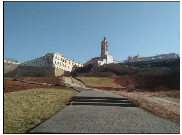
Figure 81 avancement des travaux de la promenade 14/02/2019
