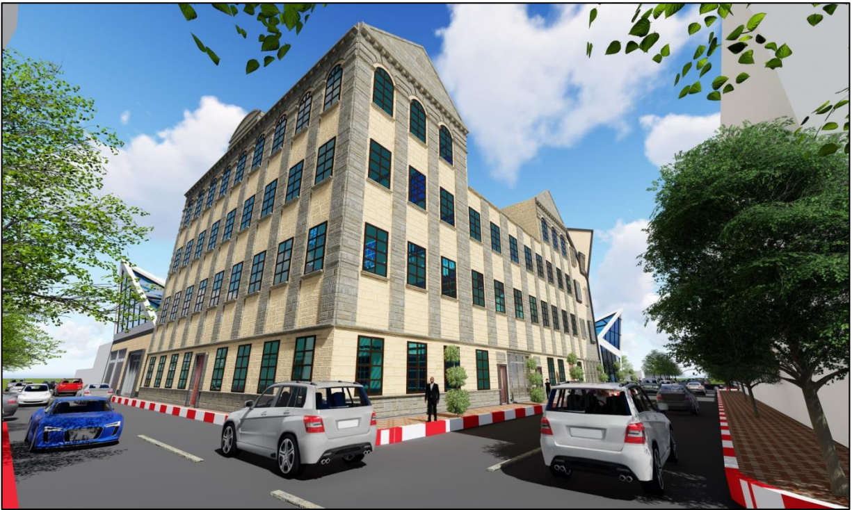
Vue à l'échelle humaine sur le bâtiment existant
