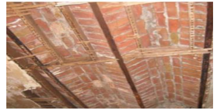
Figure 45 : Plancher en voutain
