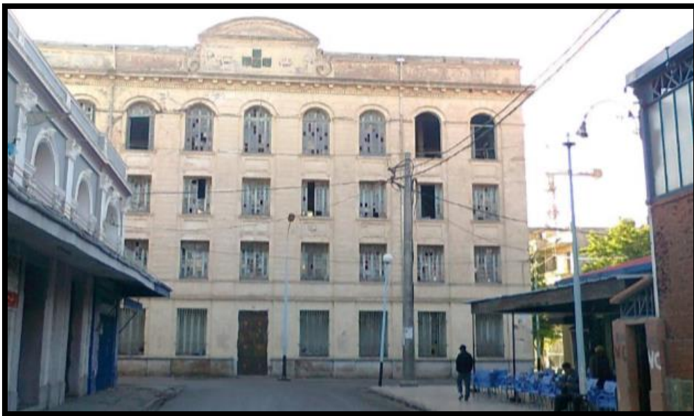
Figure 35: Vue de la façade principale de la minoterie
