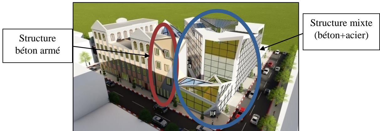
Figure 49: Type de structures utilisées dans le projet Source : auteurs
