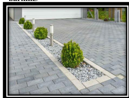
Figure 78 : pavé en béton imprimé pour les chaussées
