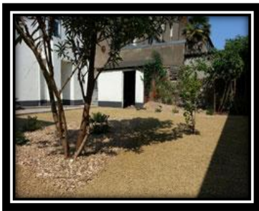
Figure 80 : pavé en sable stabilisé pour les pistes piétonnes
