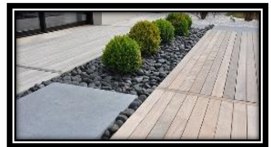
Figure 74 : pavés en bois pour les pistes au bord de mer et les berges d'oued
