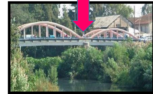
Réalisation de ponts pour piétons
