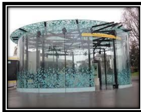
Figure 119: abris de bus en verre
