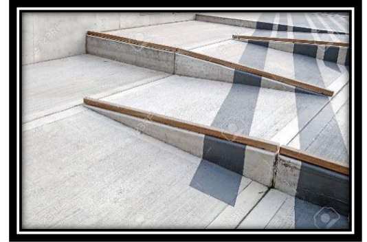
Figure 58 : Escalier avec rampe
