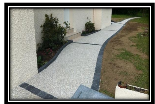
Figure 77 : pavé en béton désactivé
