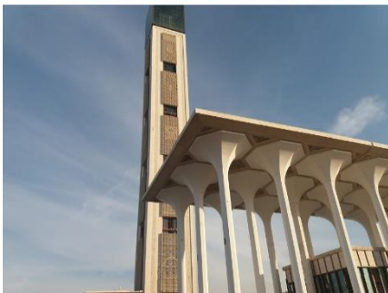
La grande mosquée de wilaya d'Alger
