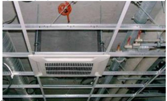
Figure 116 dispositif de ventilation en suspension
