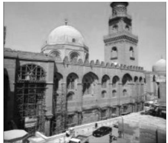
Figure 7 Bîmâristân Al Mansouri au Caire
