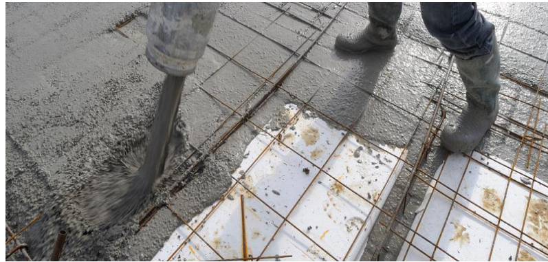
Figure 46 : utilisation du béton au dallage
