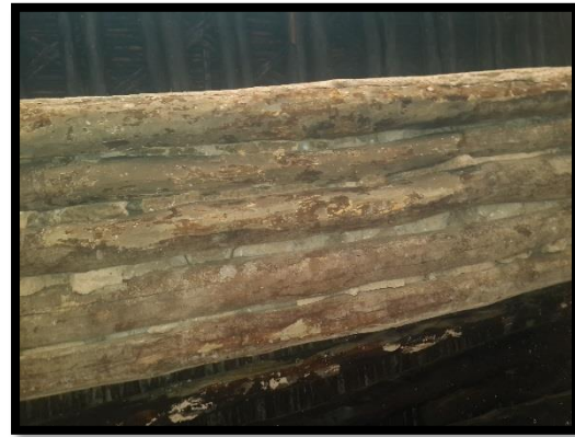
الصورة 64 تسقيف أسكوفة المدخل
