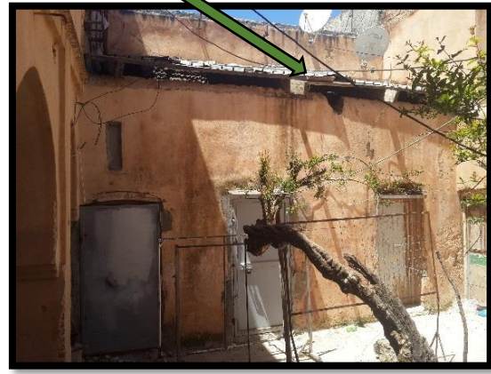
الصورة 68 تسقيف المحلات اليسرى حديثا
