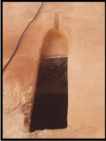
الصورة 31 فتحة فوق عقد المدخل
