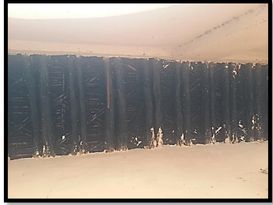
الصورة 27 سقف البائكة
