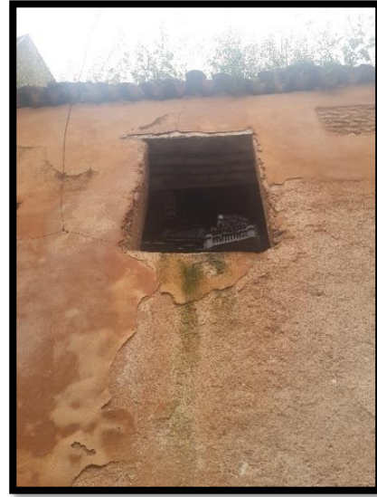
الصورة 62 تسقيف أسكوفة النوافذ
