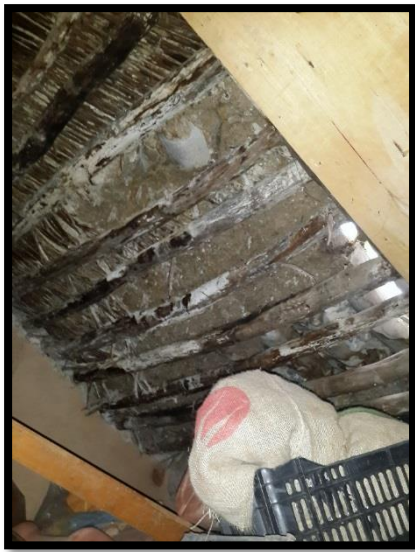
الصورة 47 سقف الغرفة اليسرى
