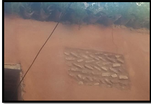
الصورة 71 طريقة المداميك المائلة السنبلية
