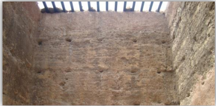
الصورة رقم 23: صورة لأحد البرجين المربعين من الداخل أثناء إعادة التسقيف
