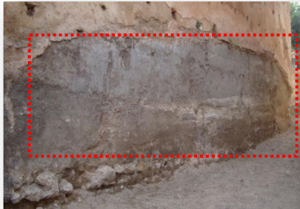
الصورة رقم 09: تلبيس اسفل الجدران بالاسمنت المسلح
