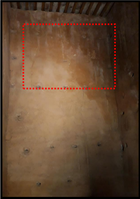
الصورة رقم 41: الرطوبة الناجمة عن تسرب مياه الأمطار الى داخل البرج المربع
