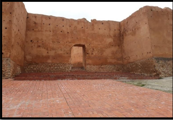
الصورة رقم 32: تخطيط أرضية المدخل بأجر مصمت
