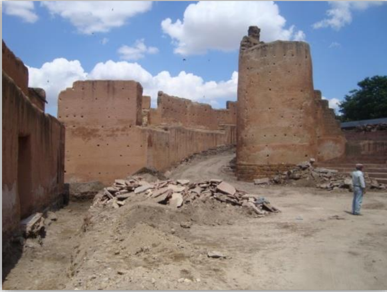
الصورة رقم 21: عفر قنوات أسفل الجدران لتجميع المياه
