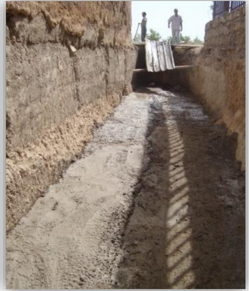
الصورة رقم 20: وضع قاعدة وطلاء الجدار بالاسمنت
