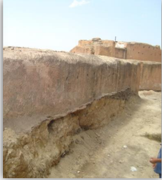
الصورة رقم 18: الحفر أسفل الجدران الداخلية للمعلم
