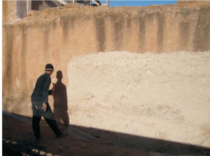
الصورة رقم 12: نزع التلبيس أثناء ترميم المعلم سنة 2011
