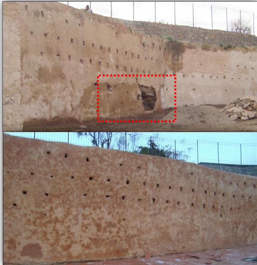
الصورة رقم 25: ترميم الفجوات الكبيرة في الجدران
