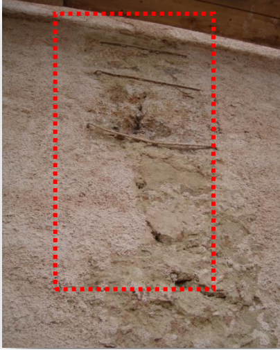
الصورة رقم 06: ترميم الجدار الشرقي باستخدام المساسيك
