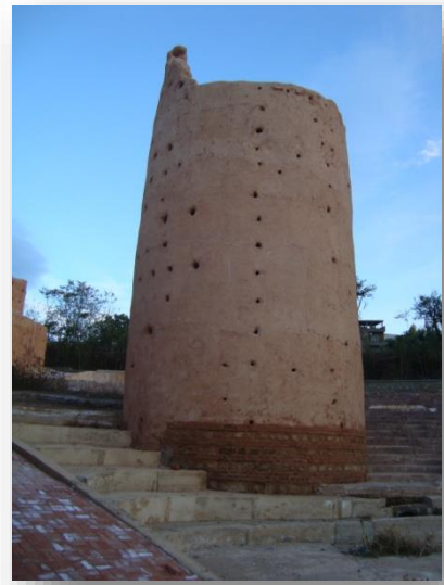
الصورة رقم 28: البرج الشرقي بعد الترميم
