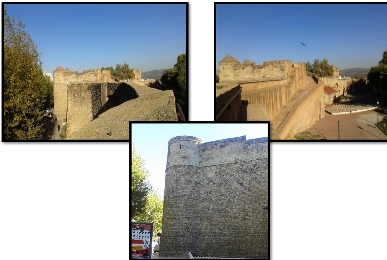
Figure 48: vue sur le rempart.
