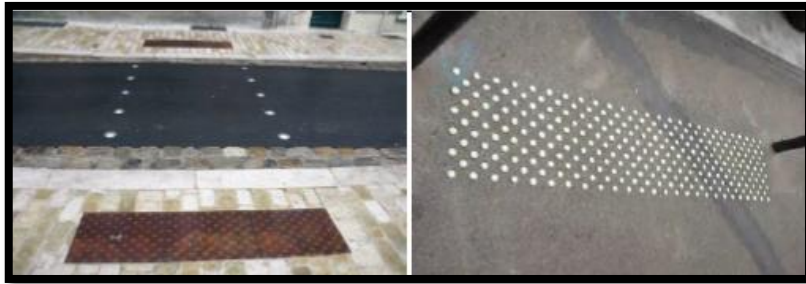
Figure73. DALLE PODOTACTILE Fonte ductile – non glissant 400x420mm, épaisseur 10 mm.
